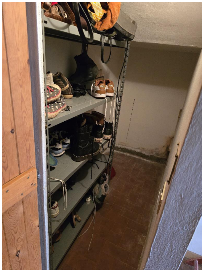
Sottoscala con probabile umidità di risalita
