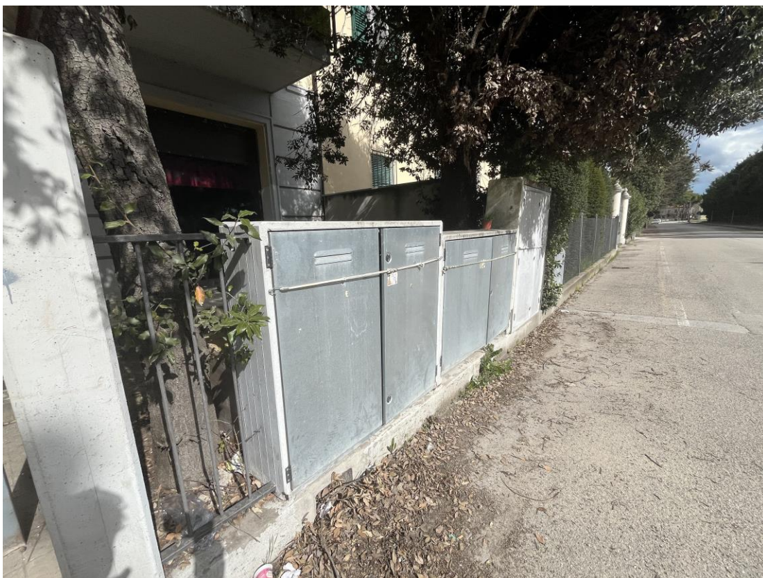
Contatori posti sulla recinzione esterna fronte strada
