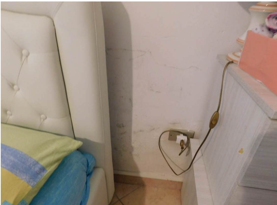
Foto 15 – Interno abitazione – Particolare danni alle pareti da umidità di risalita.
