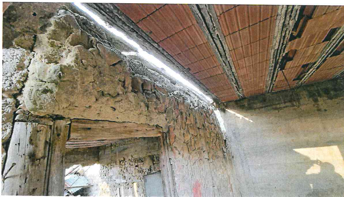
FOTO 6 (PARTICOLARE DEL DISSESTO DELLE STRUTTURE E DEL SOLAIO)
