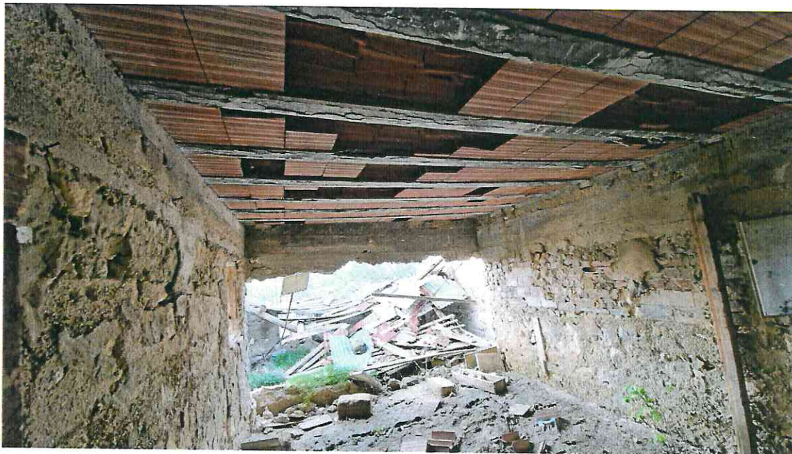
FOTO 5 (PARTICOLARE DEL DISSESTO DEL SOLAIO)
