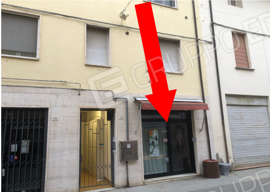
Vista generale dell'unità immobiliare, su Corso Vittorio Veneto
