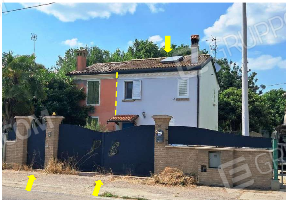
VISTA PROSPETTO PRINCIPALE DALLA STRADA VIA ROSSETTA INDICAZIONE DEGLI INGRESSI E INDICAZIONE DELLA PORZIONE IN OGGETTO
