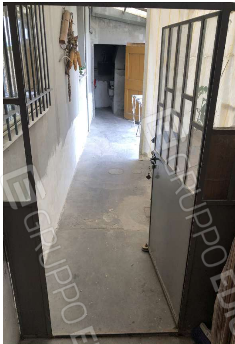
Foto 10: Particella 105, Subalterno 3, piano T
