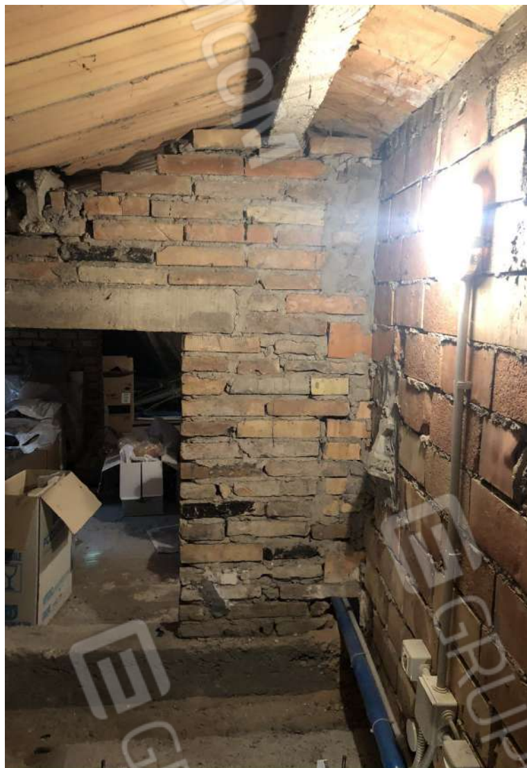
Foto 27: Particella 105, Subalterno 3, piano sottotetto
