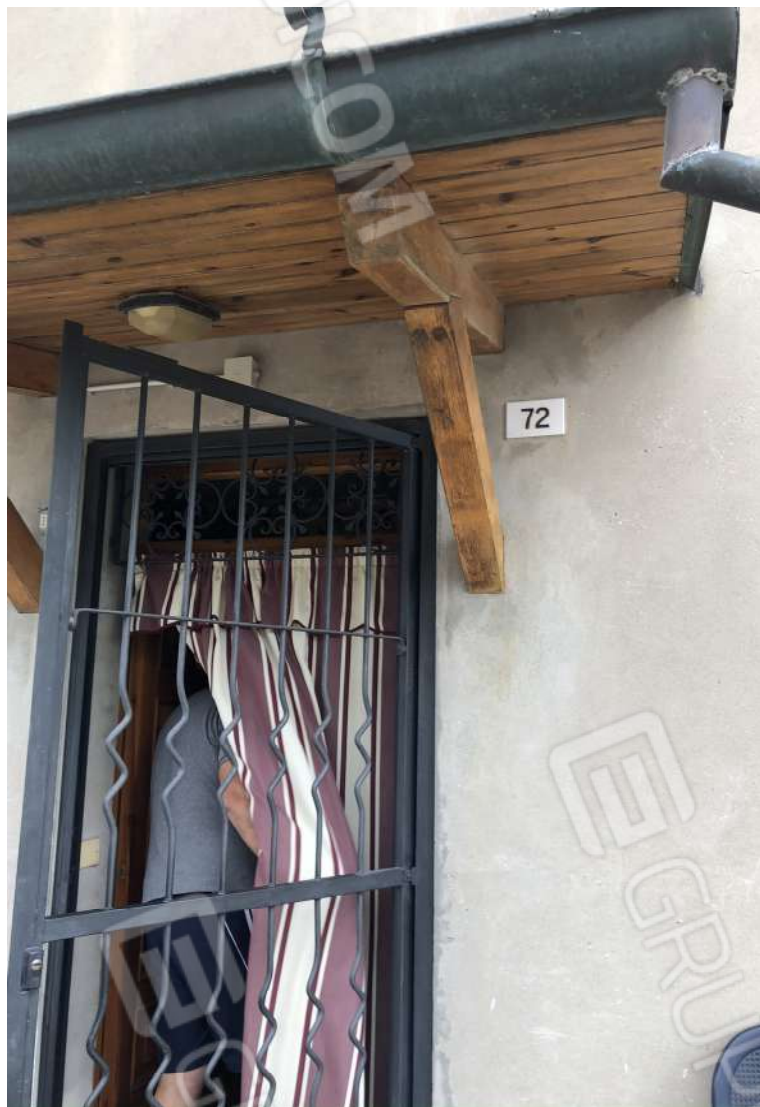
Foto 29: Particella 105, Subalterno 2, piano T
