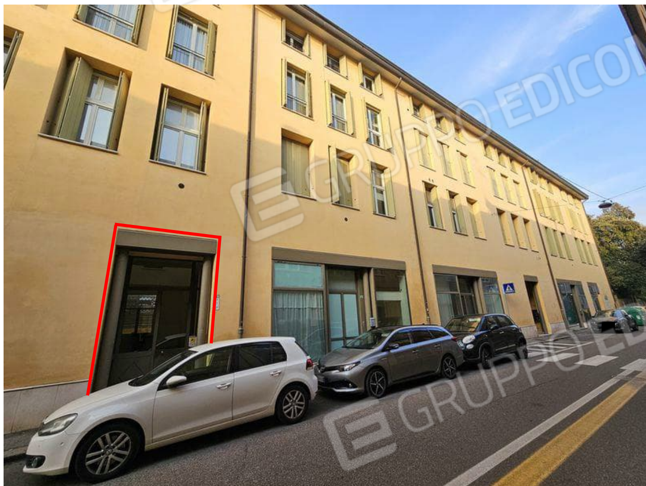
Vista su ingresso pedonale comune da via Giulio Alberoni
