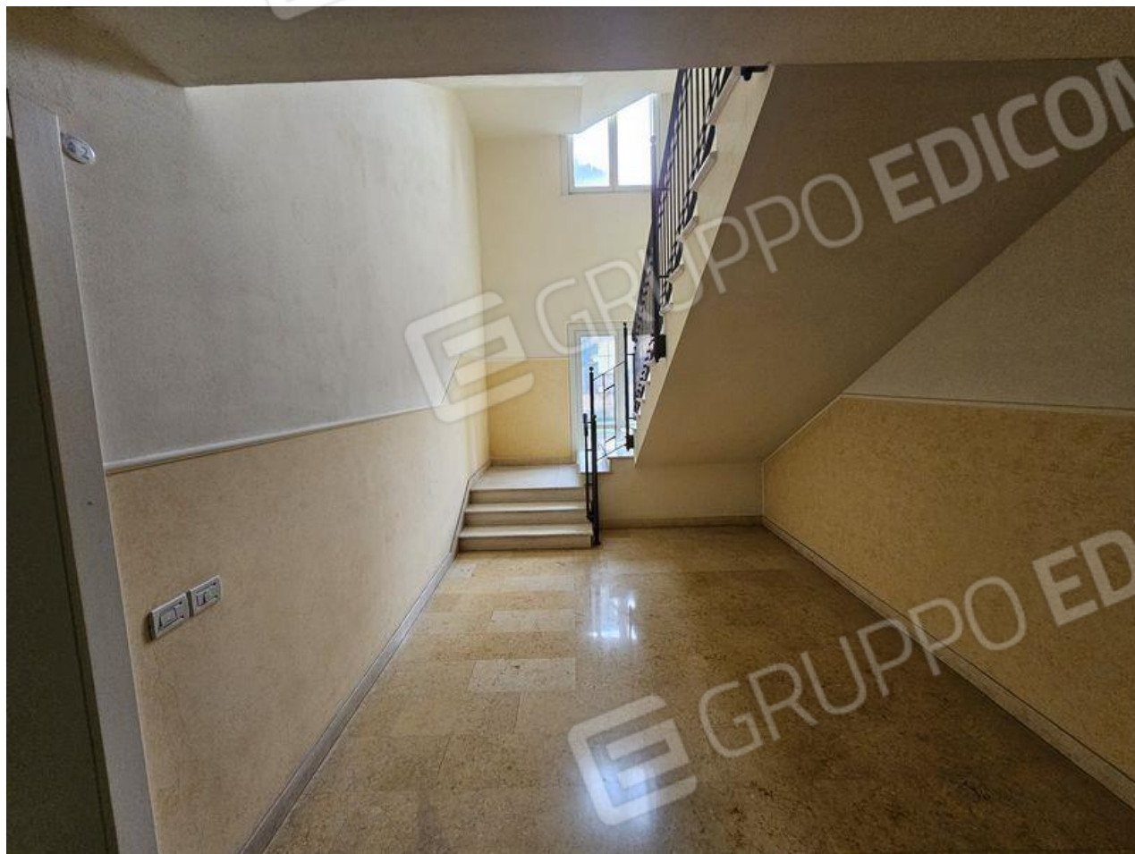
Ingresso comune con vista su scala per accesso al P1(PT)
