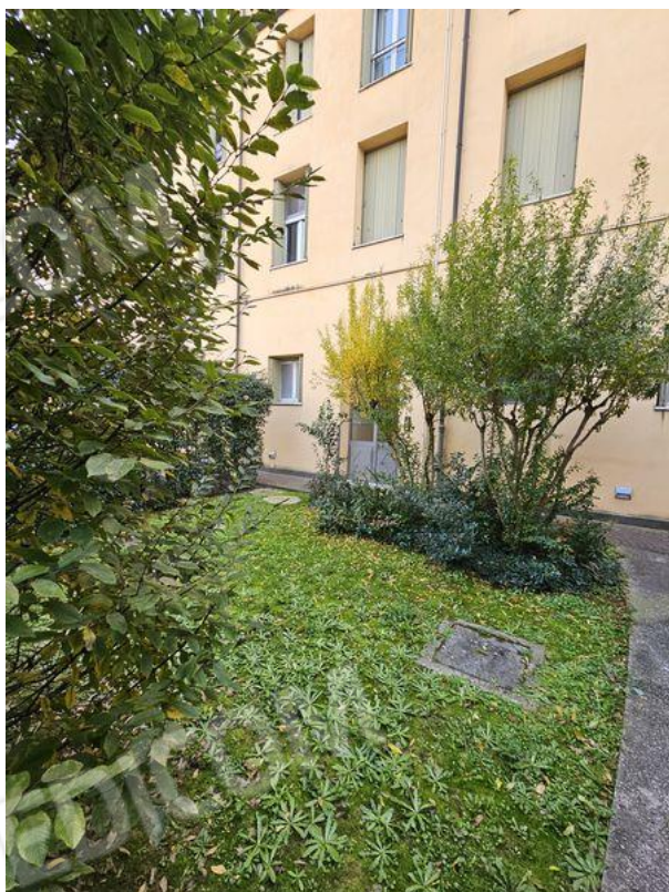
Vista su ingresso comune e cortile condominiale interno
