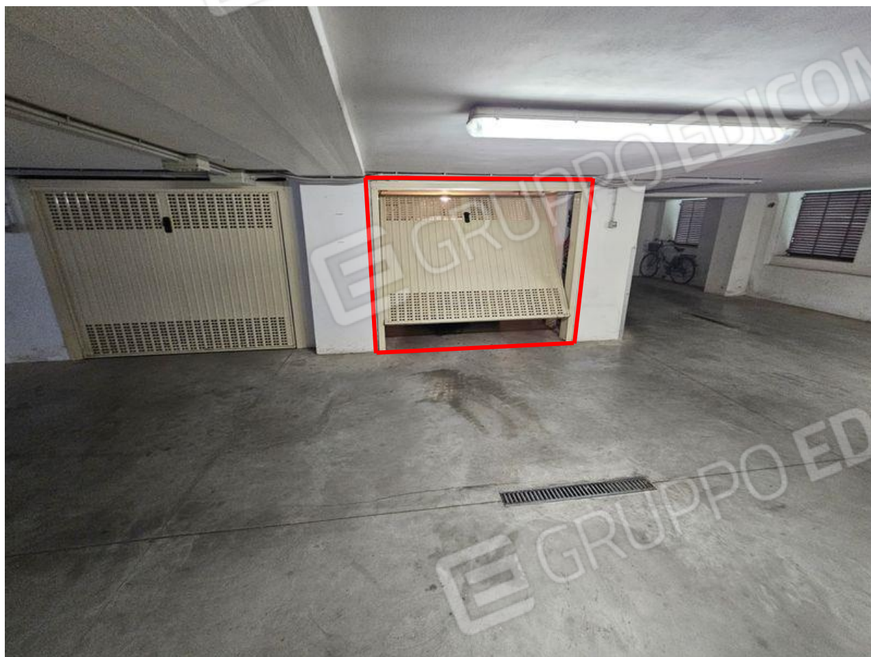
Accesso carrabile e pedonale a garage (S1)
