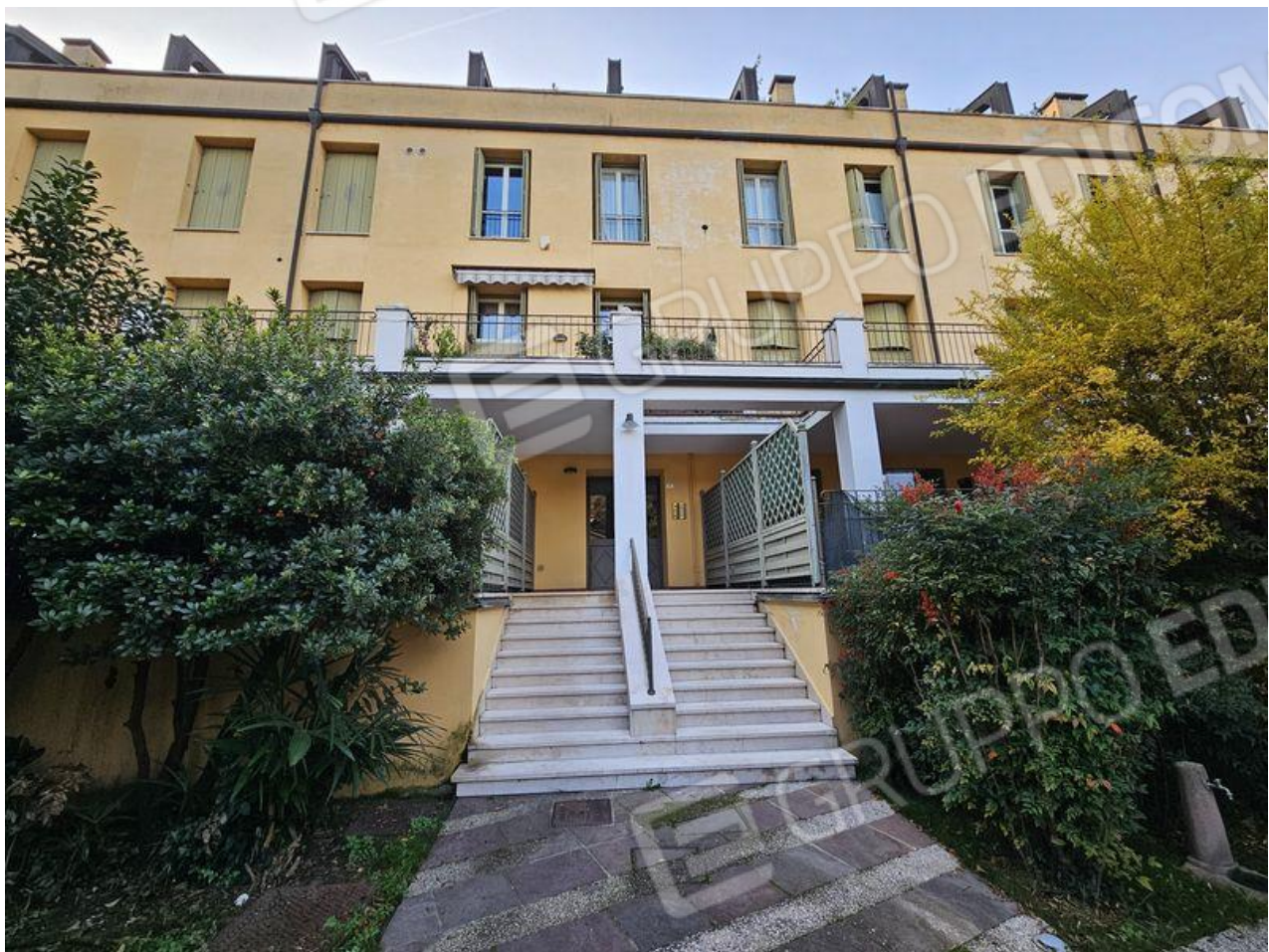
Vista su ingresso comune e cortile condominiale interno
