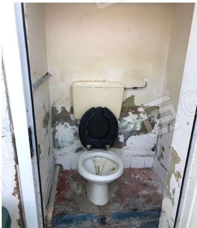
Vista latrina accessibile dall'esterno, posta sul retro dell'abitazione.
