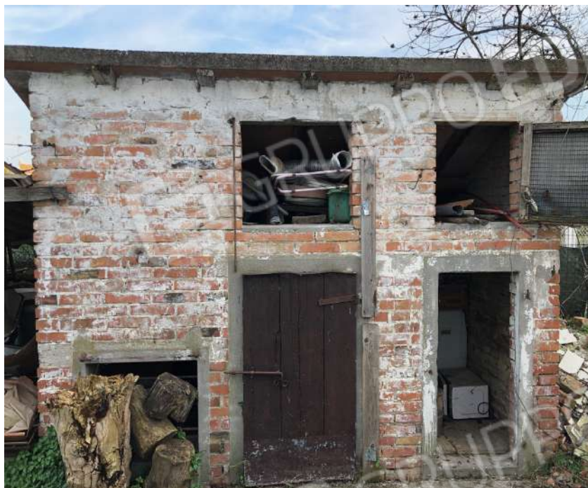
Vista servizi in corpo staccato, ex porcilaia.
