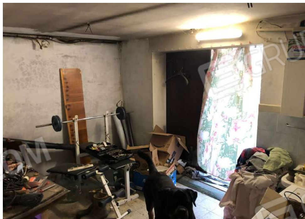
Vista cantina al piano terra.
