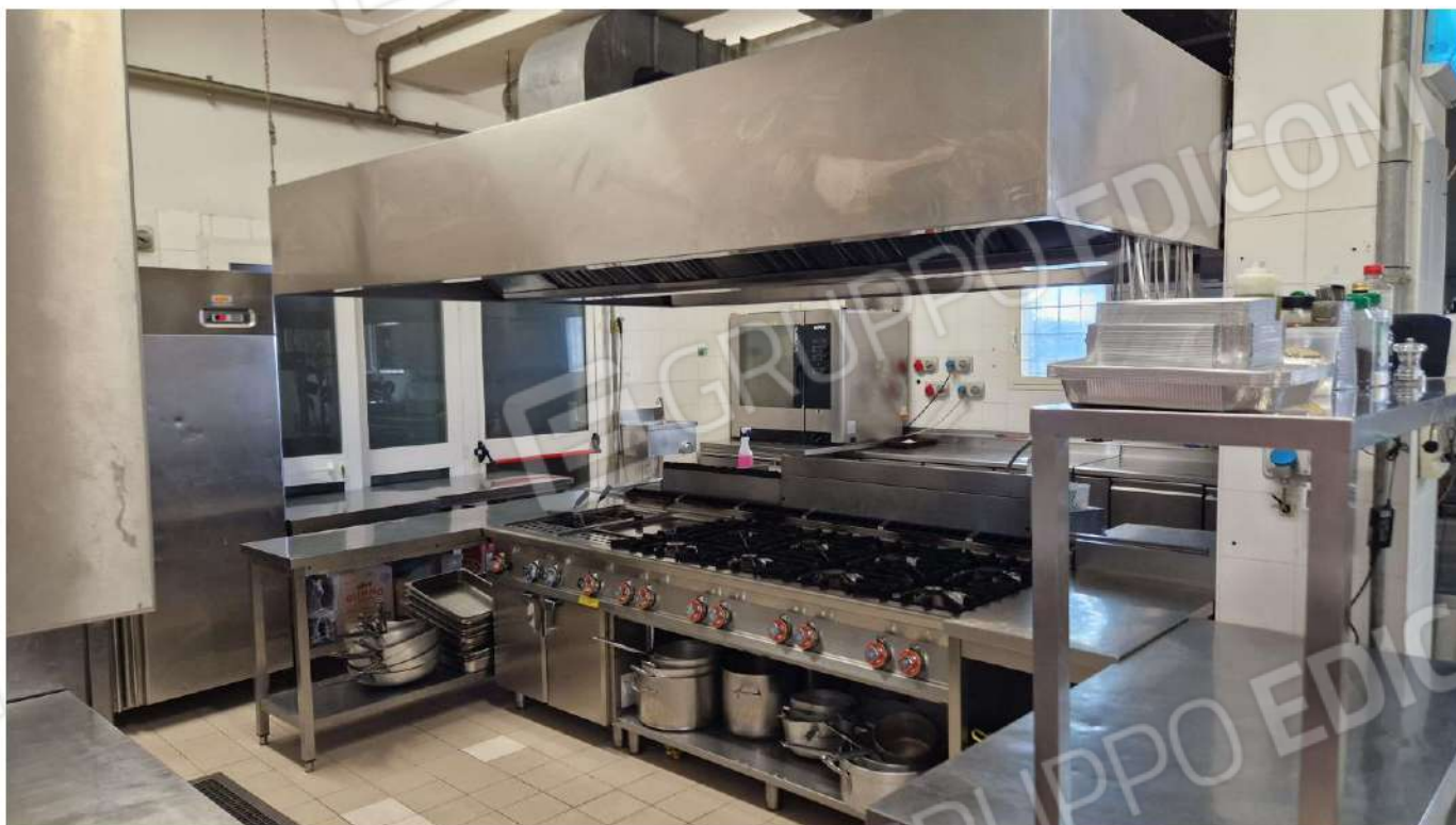
Locale cucina adiacente – vista sull’accesso esterno dalla Via Molinello
