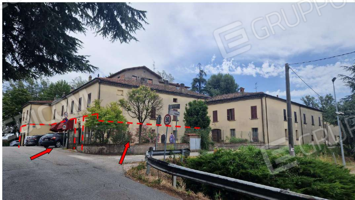
Vista laterale ovest dalla Via Molinello
