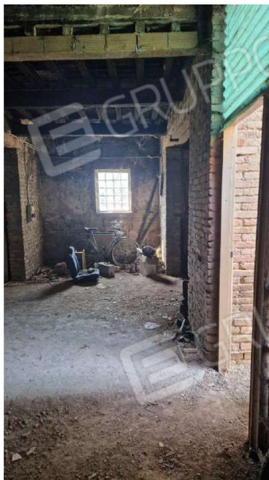
Altra tettoia – vista opposta
