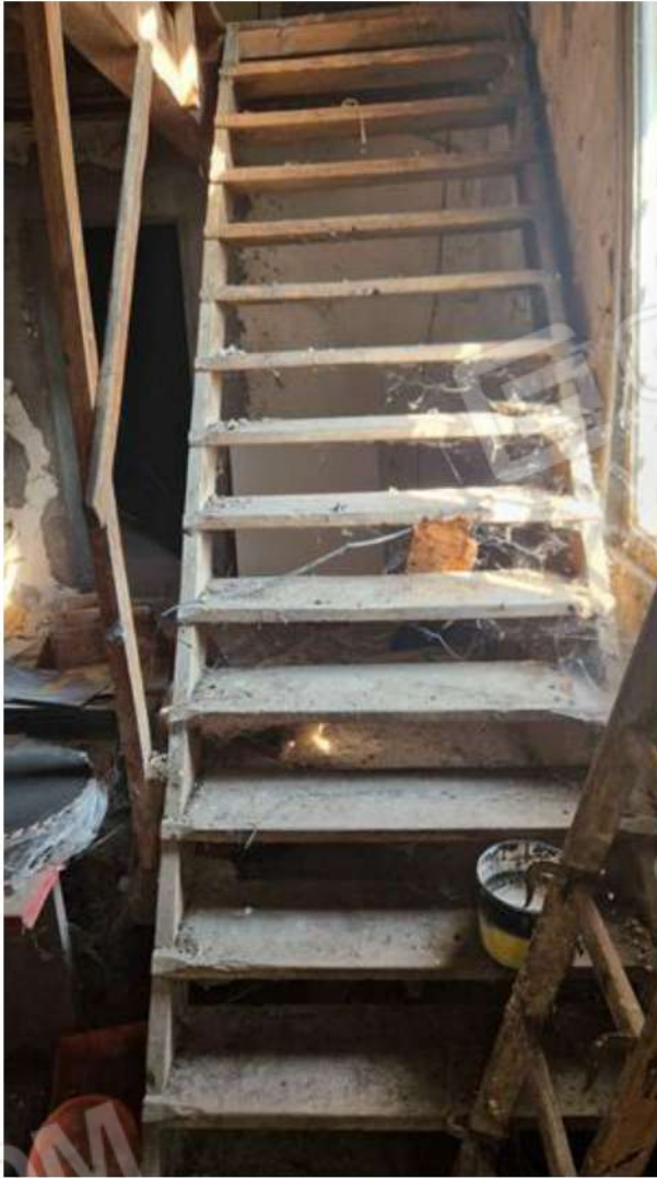
Scala di accesso al piano secondo (dal 1°deposito)
