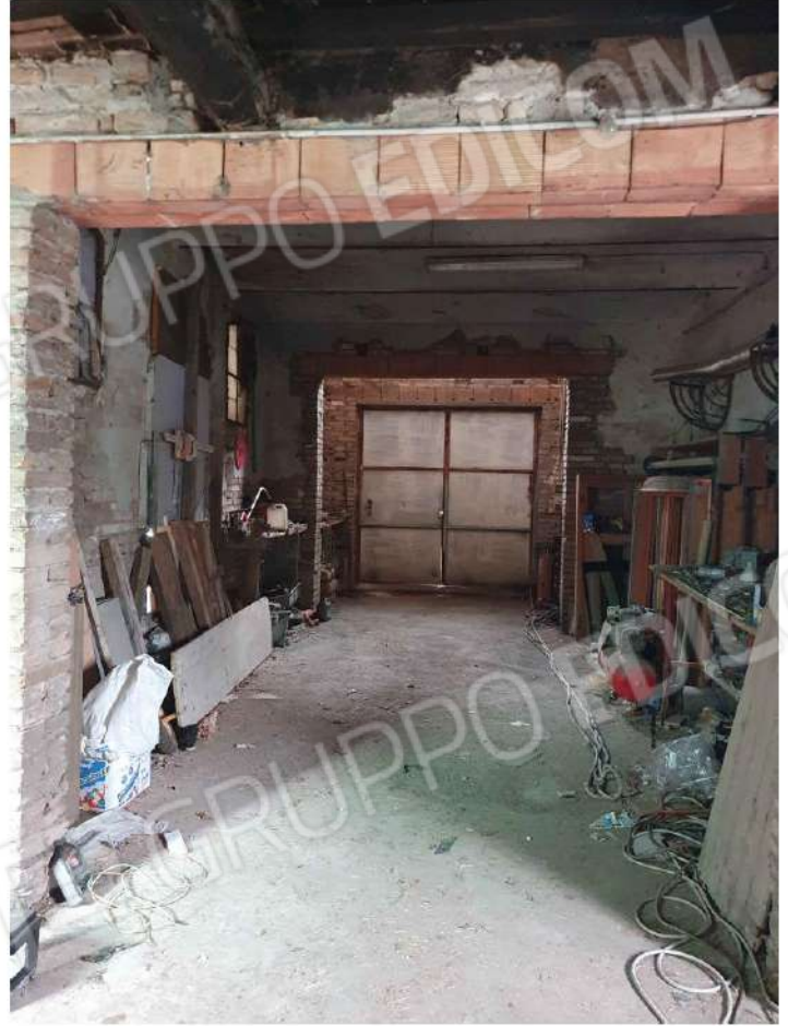
Garage - Sub.10 (vista verso l'accesso esterno)
