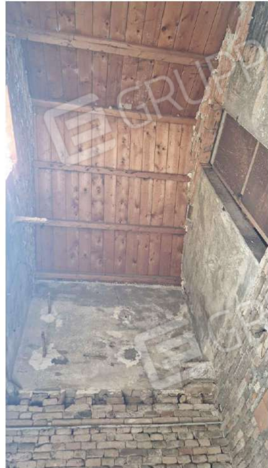
Vista particolare tetto
