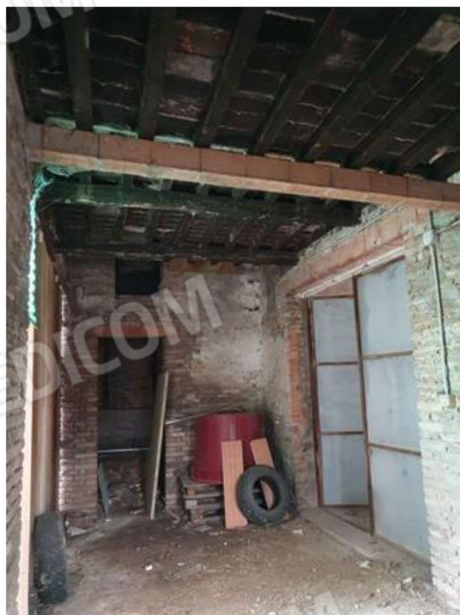
Altra tettoia – vista verso l'accesso al magazzino 5
