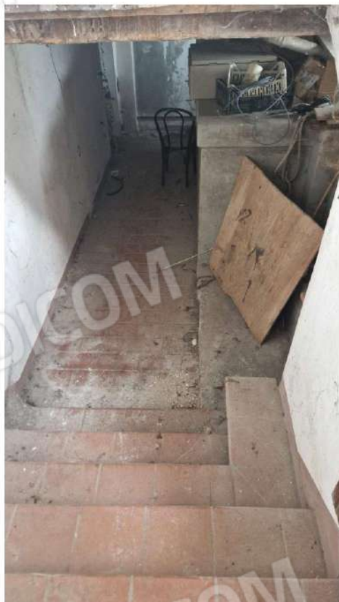
Vista dal vano scala
