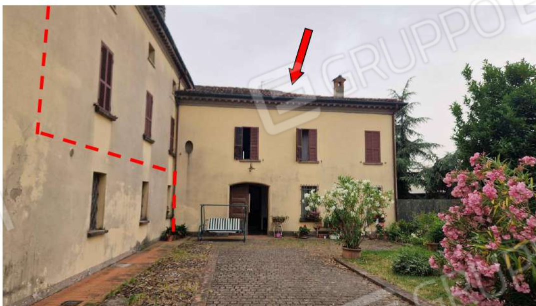
Vista frontale dalla corte interna comune
