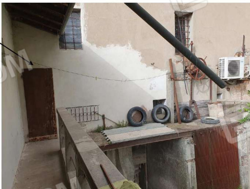
Cucina – ballatoio esterno (vista sull'ingresso esterno ai locali di servizio ex mulino / sub. 14)
