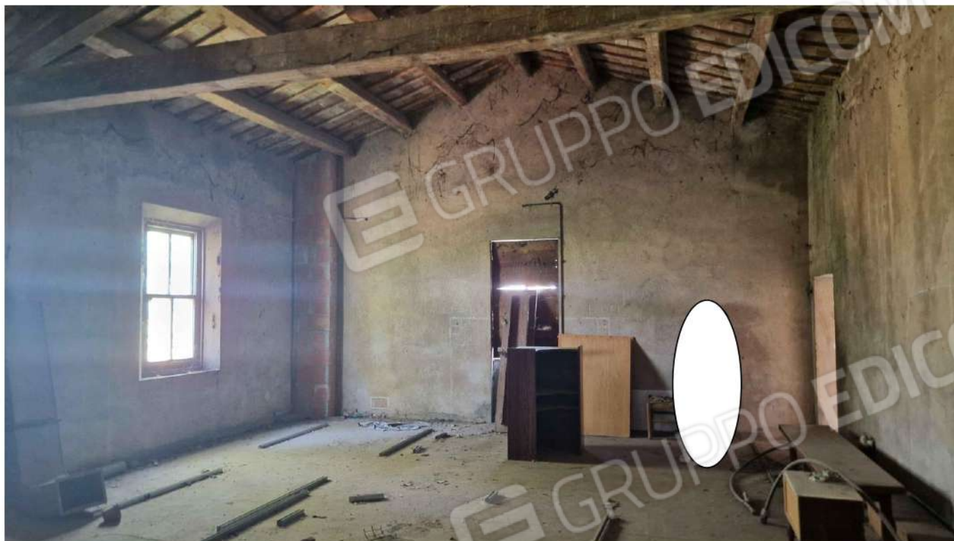
3° Deposito – vista sull'accesso
