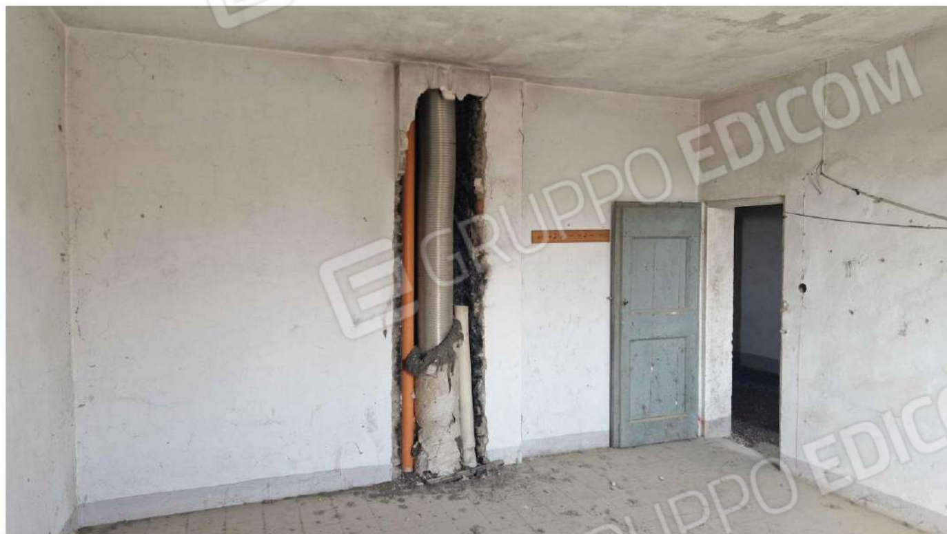
Camera – 2 (altra vista verso l'accesso dal disimpegno)
