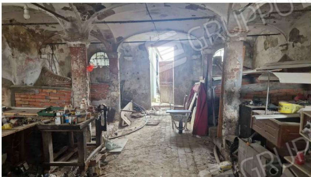
Stalla – vista opposta sull’accesso esterno dal retro del fabbricato
