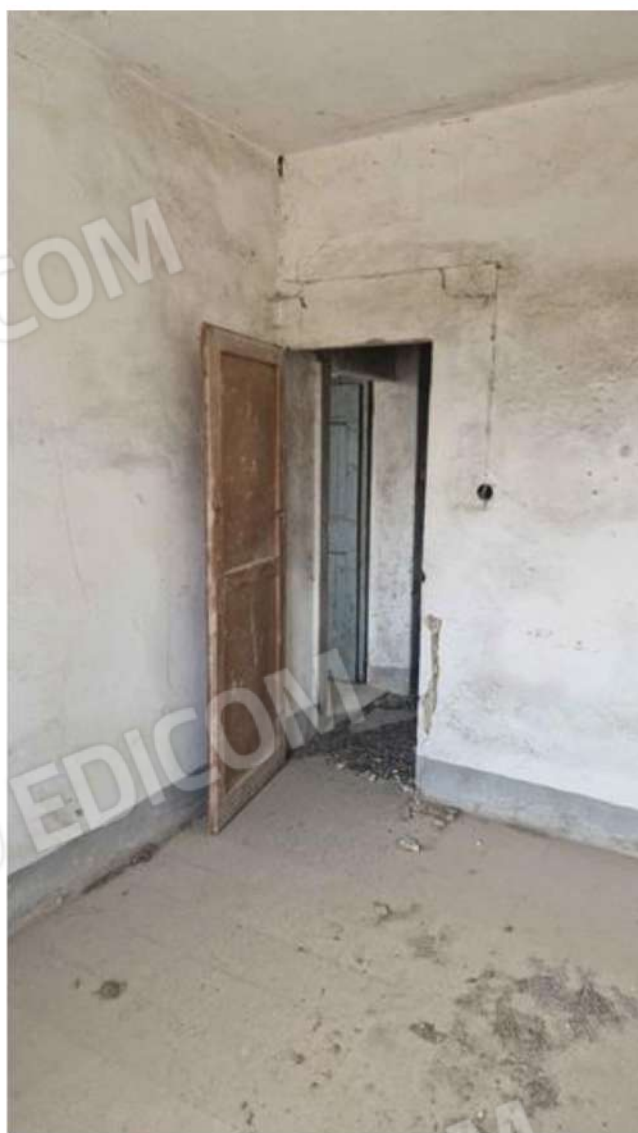
Ripostiglio – vista verso l'accesso dal disimpegno
