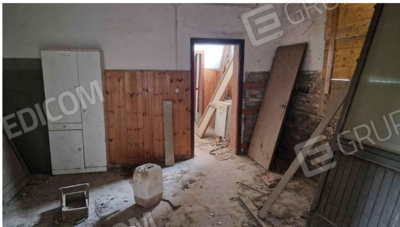
Cucina – vista verso l'ingresso
