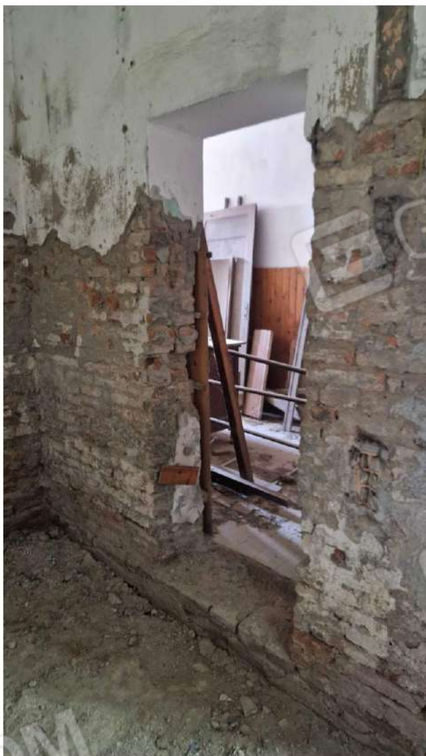
Zona del Bagno – vista verso l'ingresso
