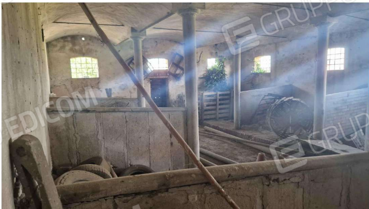
Stalla – vista sull'accesso esterno dal lato nord del fabbricato
