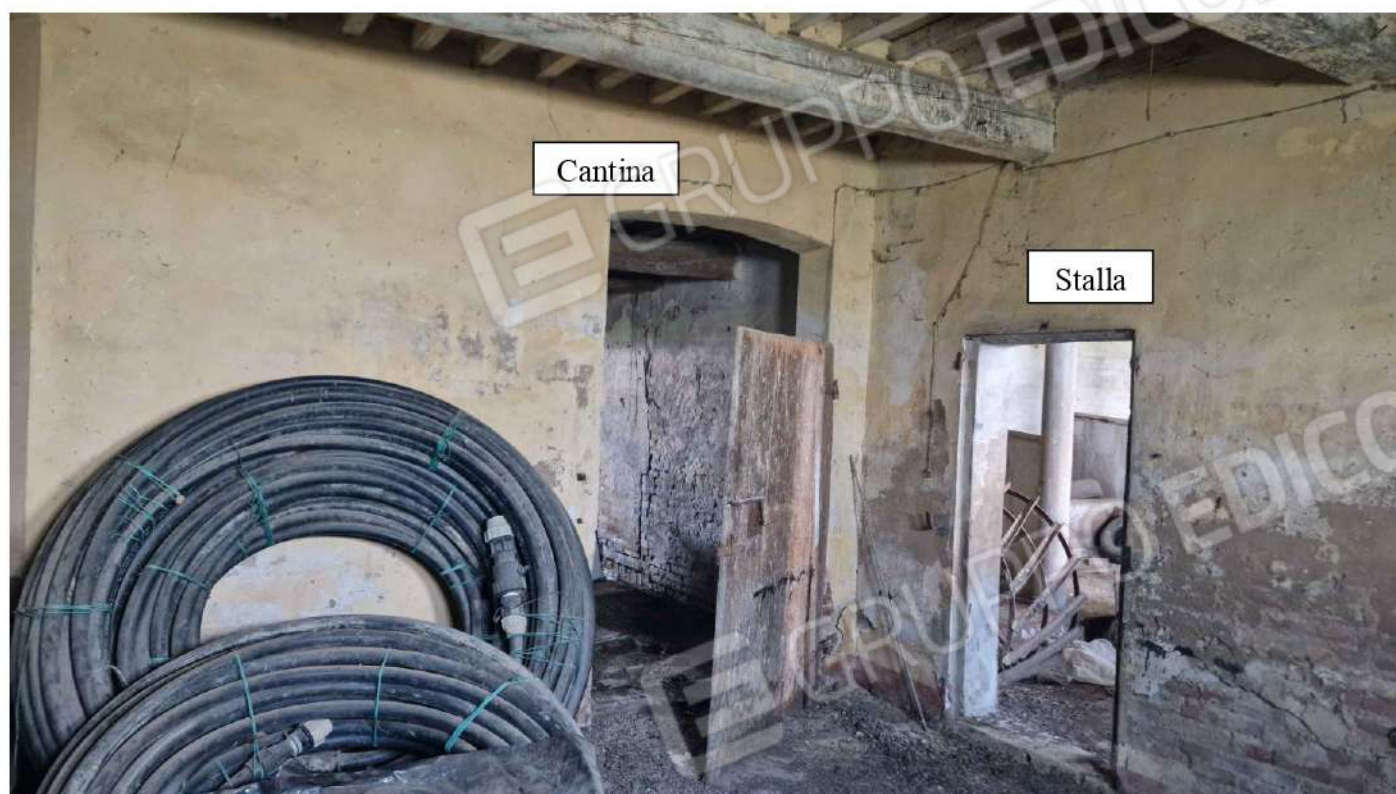
Ingresso – vista sull'adiacente stalla e cantina
