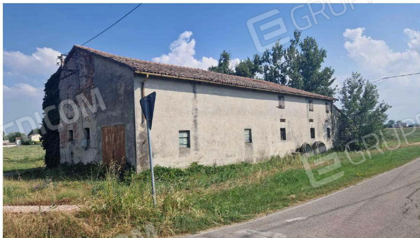
Vista lato nord e posteriore ovest dalla Via Nuova
