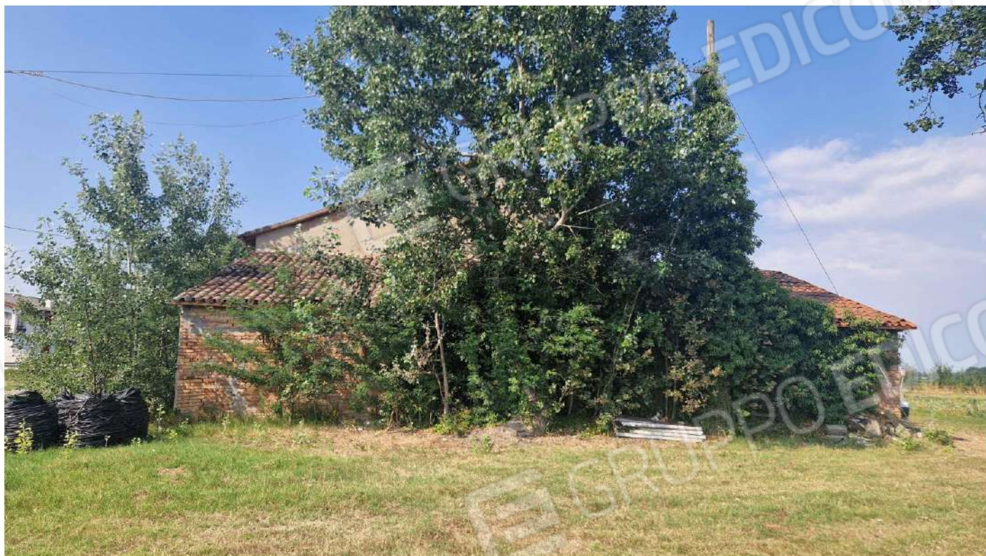
Vista lato sud (ricovero attrezzi esterno)
