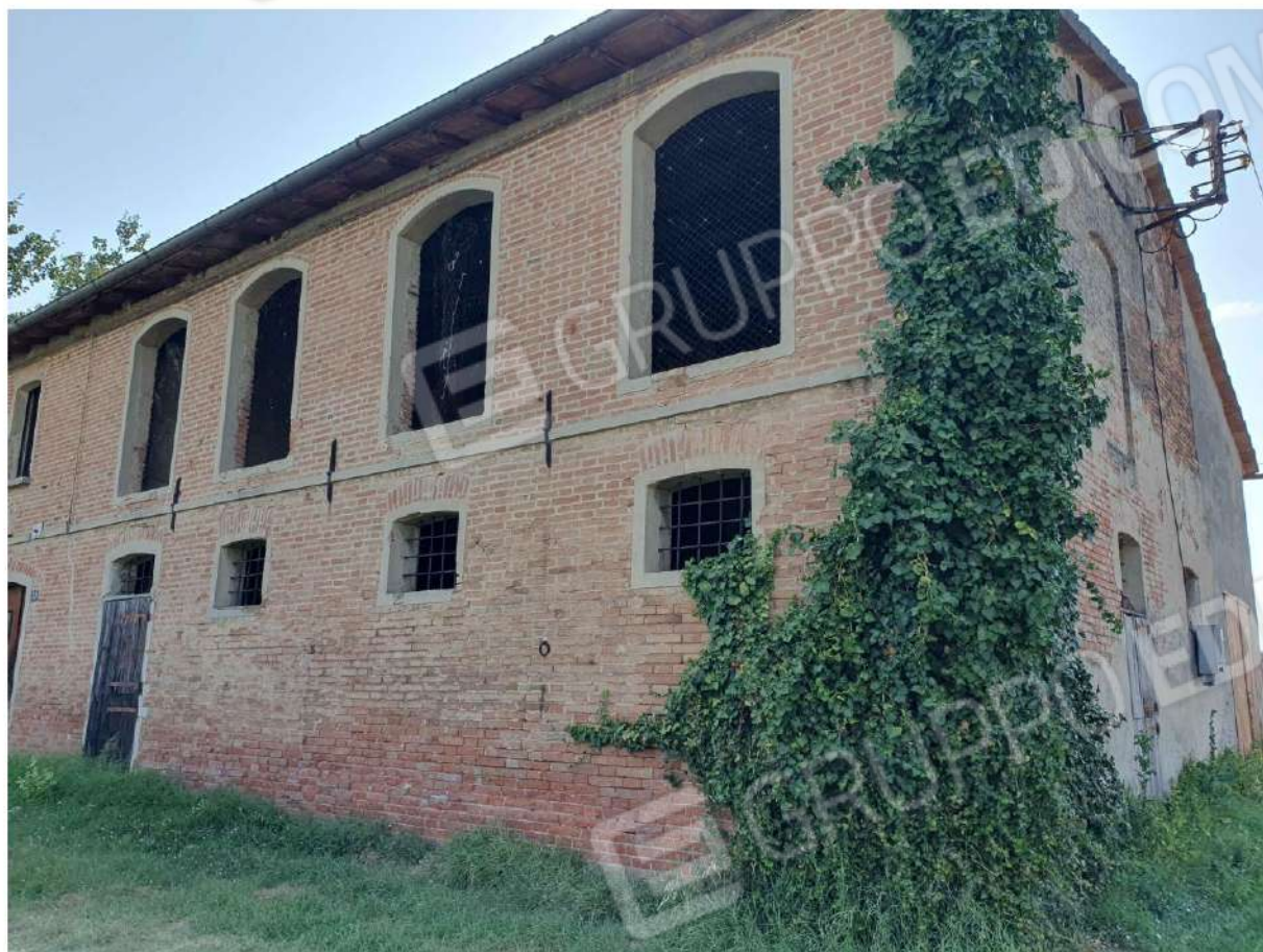
Dettaglio facciata principale - vista sulla stalla al p. T e fienile al p. 1°
