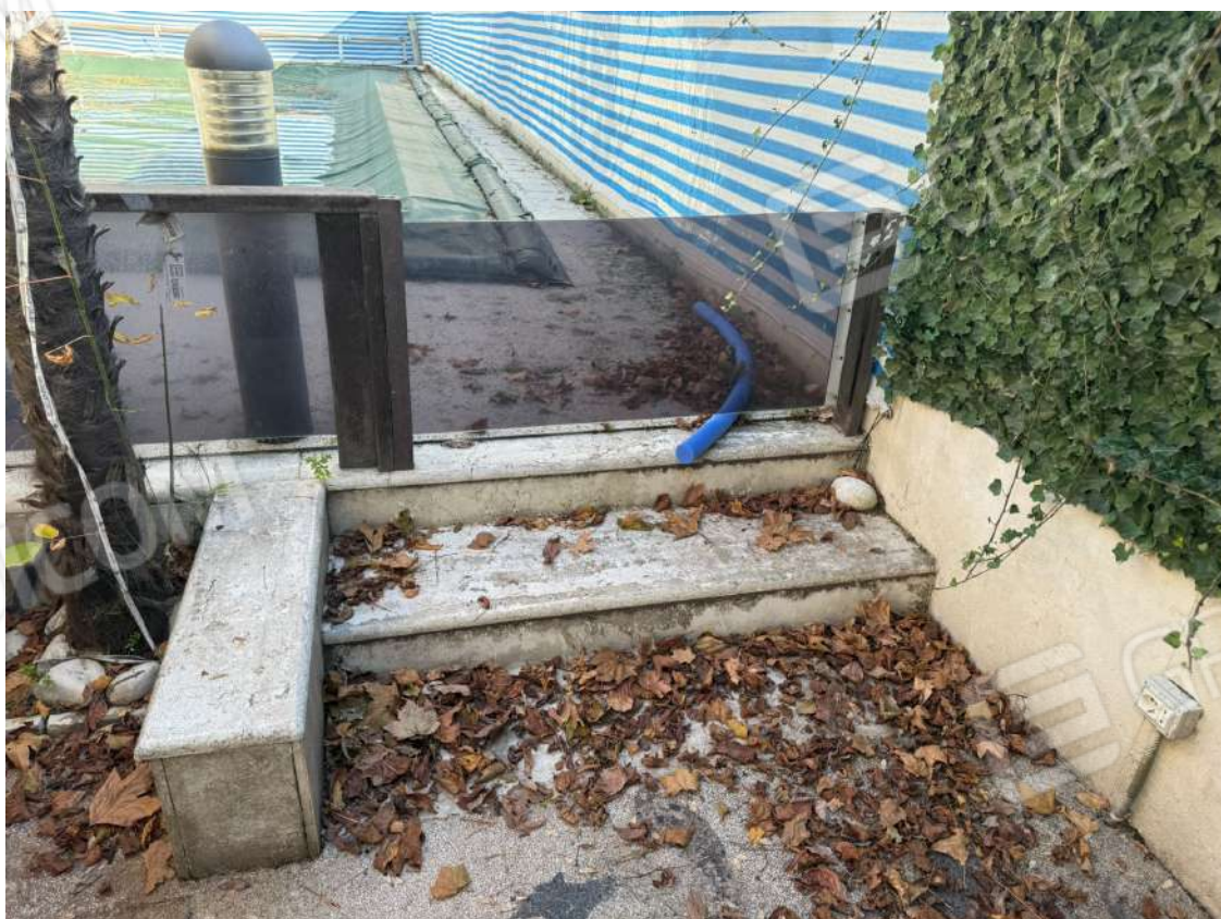
Foto 30: Area esterna - Bordo piscina e recinzione
