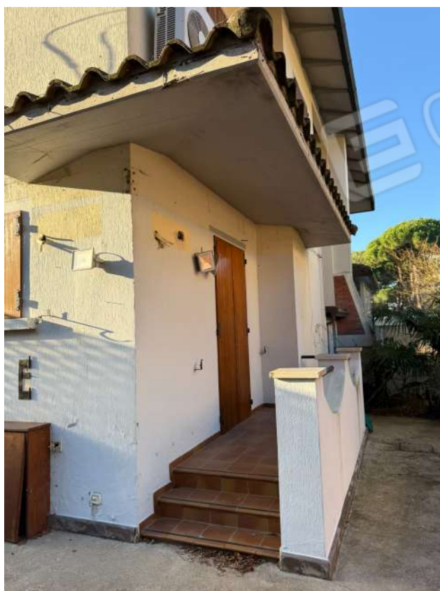
Foto 8: Ingresso secondario e portico esterno
