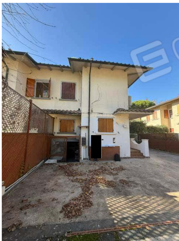
Foto 6: Retro del fabbricato
