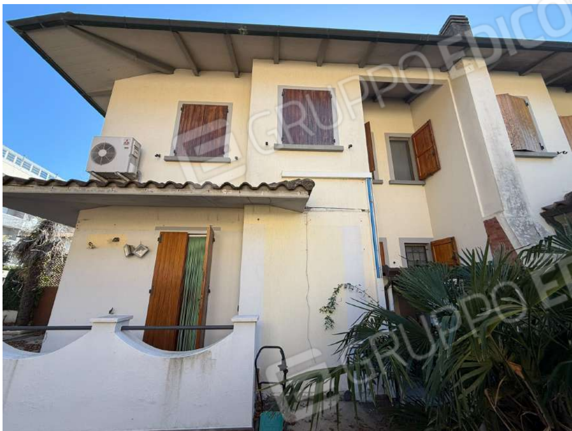
Foto 3: Prospetto laterale del fabbricato
