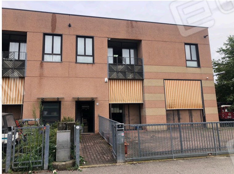
Fronte via Pontenono
