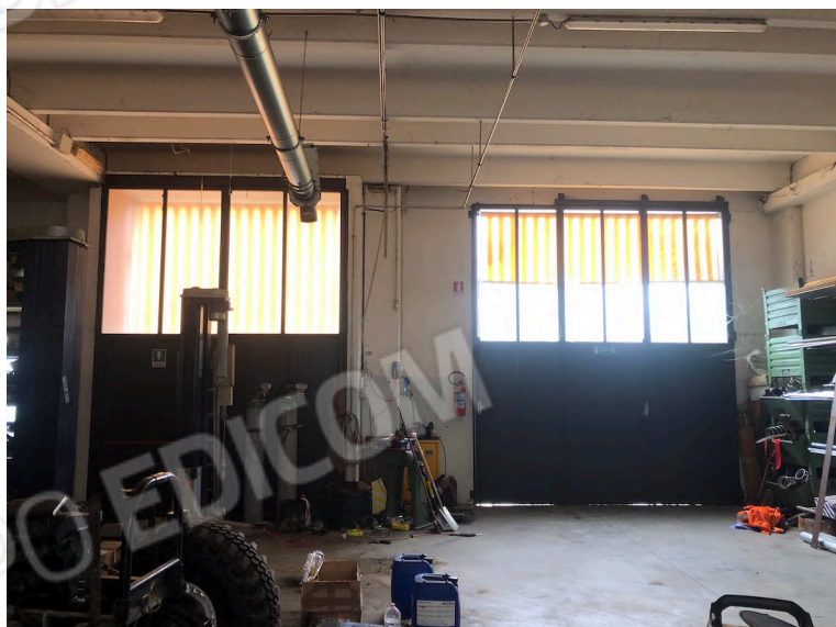
Interno deposito PT portoni sul fronte
