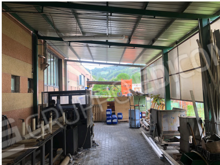
Area sul retro coperta da tettoia
