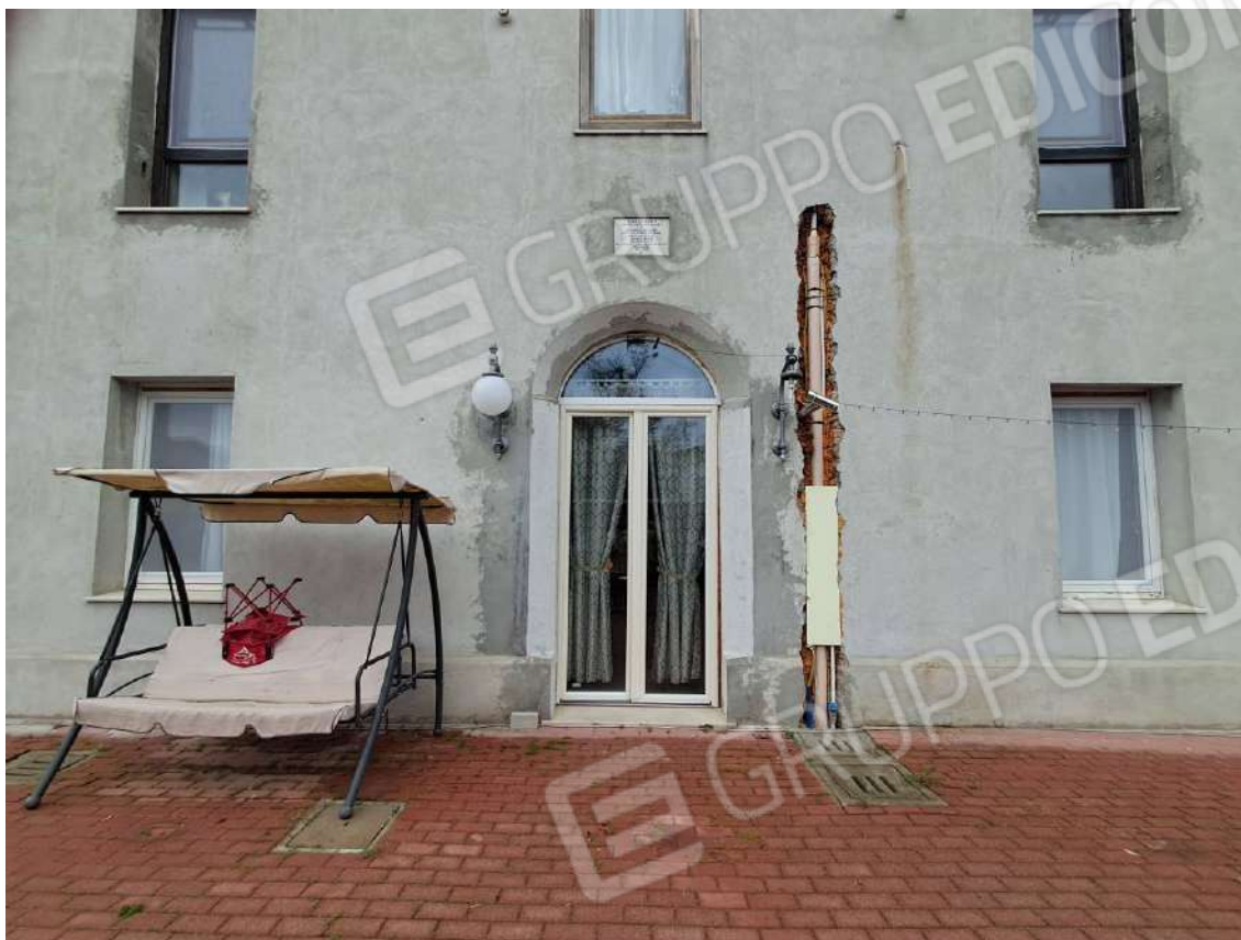
PARTICOLARE PROSPETTO OVEST DEL FABBRICATO
