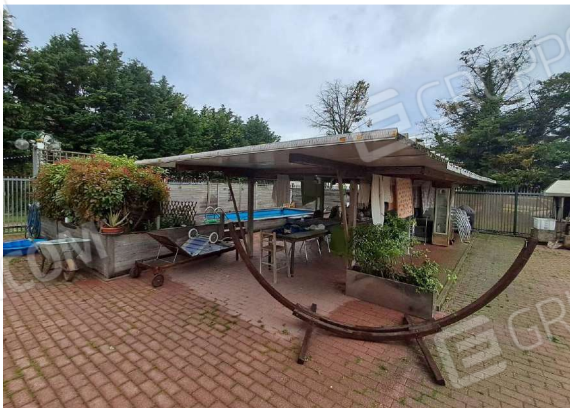
CORTE CON PISCINA DA REGOLARIZZARE E COPERTURA DL PERGOLATO DA RIMUOVERE
