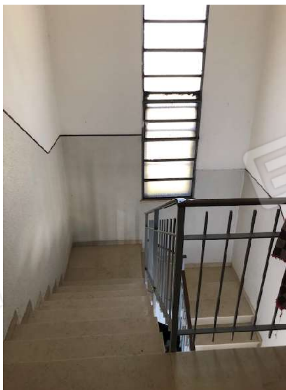
Foto 10 – vano scala sub 2
