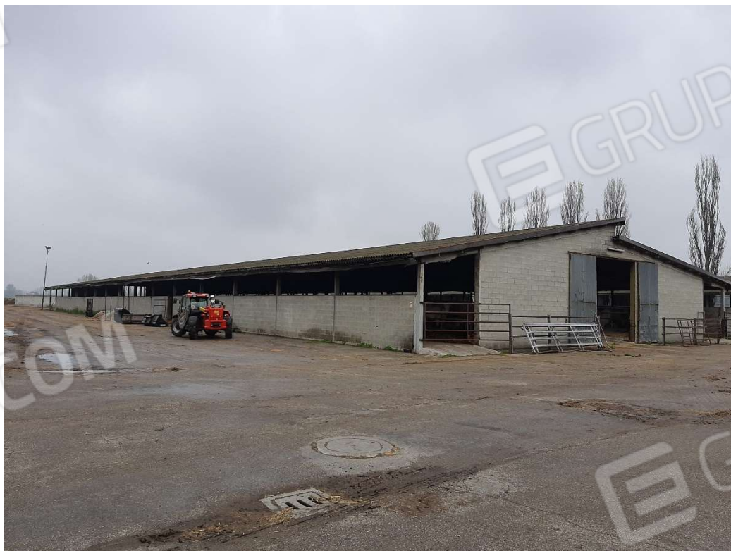
Foto 25 – Subalterno 6 – fabbricato “B”
