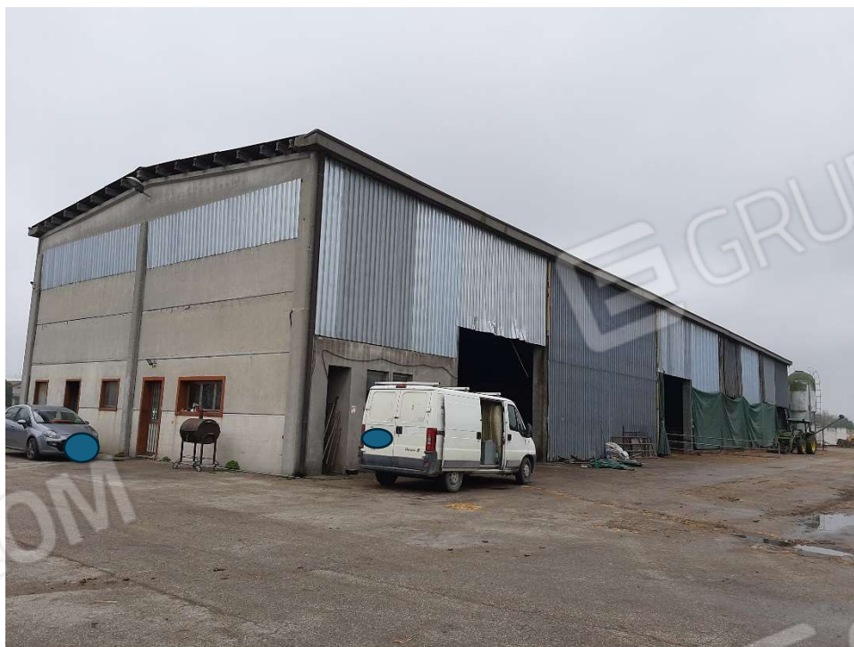
Foto 15 – Sub. 6 fabbricato "A"
