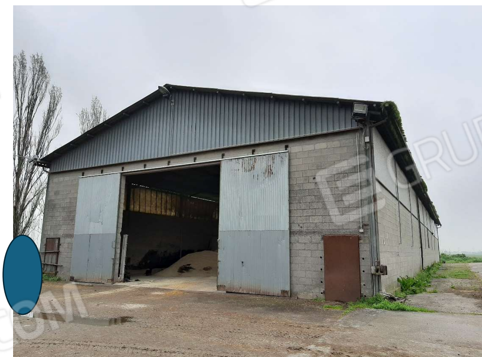
Foto 27 – Subalterno 6 – fabbricato “D”
