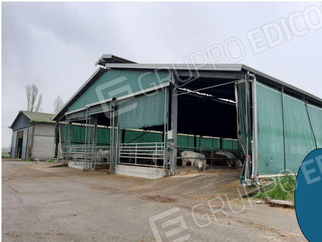
Foto 28 – Subalterno 6 – fabbricato “E”
