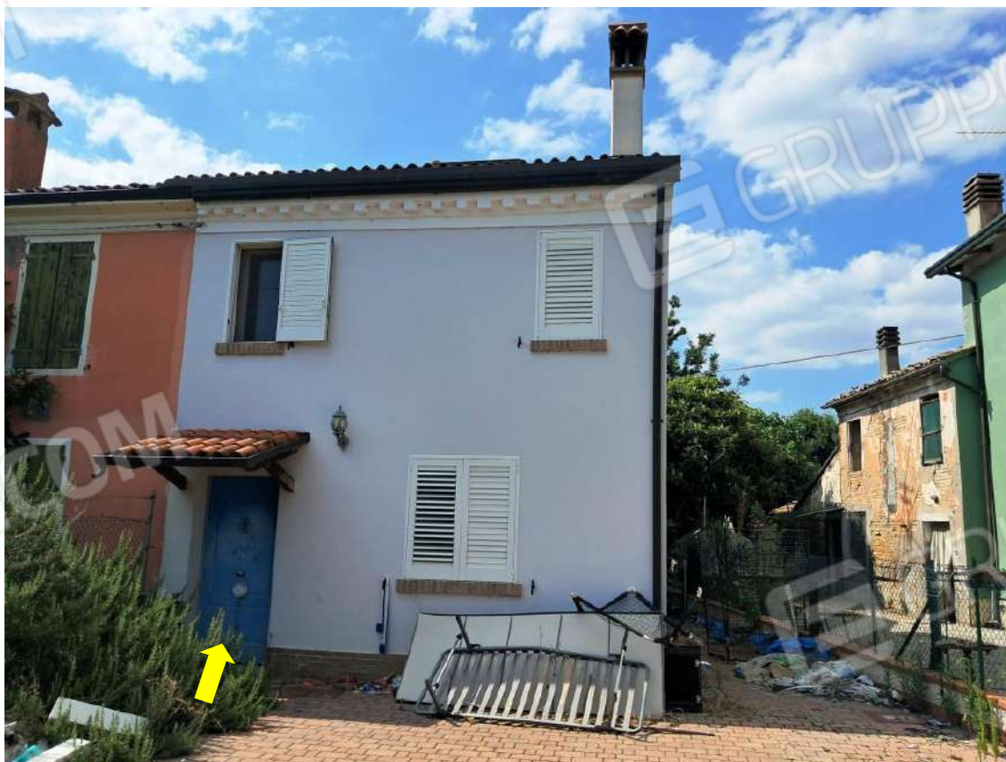
PROSPETTO PRINCIPALE E INGRESSO DELL'ABITAZIONE
