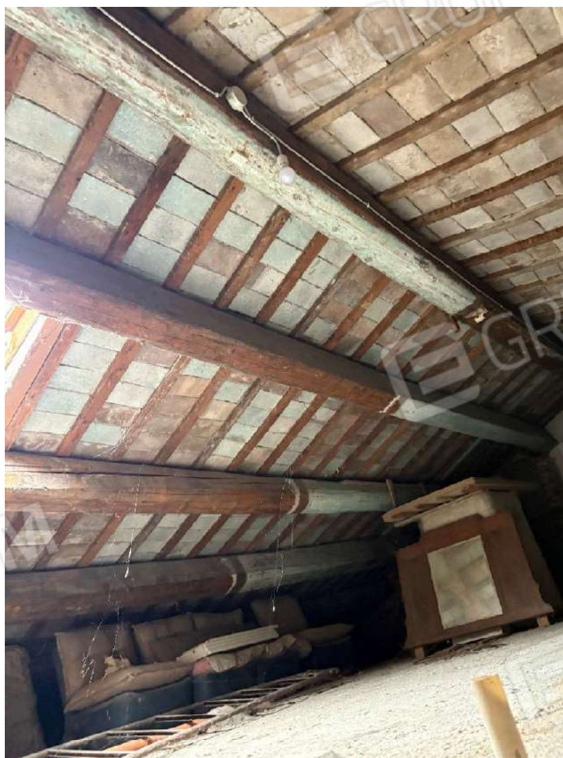
FOTO 33 e 34: SUB. 8 – SOTTOTETTO
