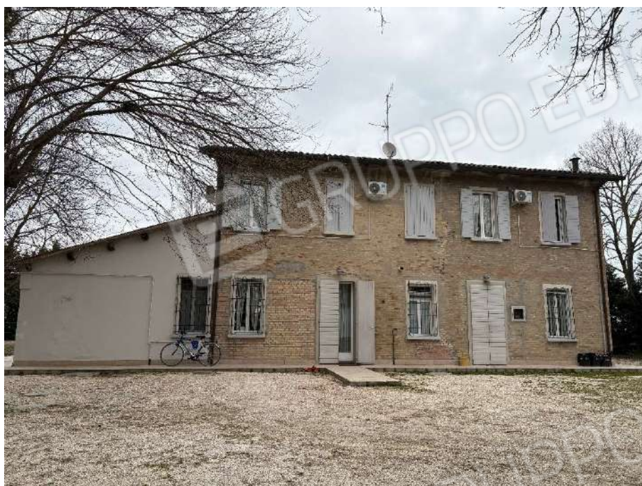
FOTO 5: FRONTE FABBRICATO PRINCIPALE
