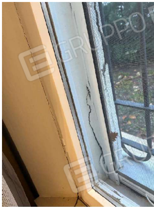
FOTO 45 e 46: SUB. 9 – PARTICOLARI CREPE AL PIANO TERRA
