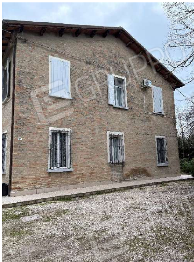
FOTO 7: PROSPETTO LATO STRADA
