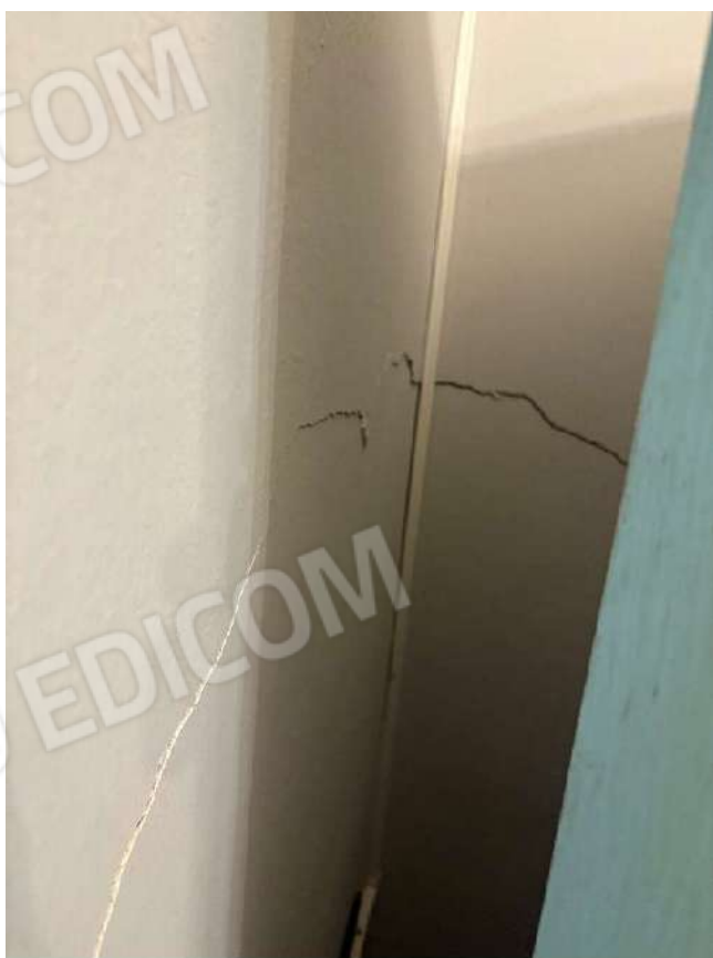
FOTO 45 e 46: SUB. 9 – PARTICOLARI CREPE AL PIANO TERRA
