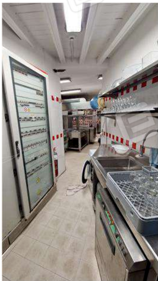
Altra vista opposta verso la cucina
