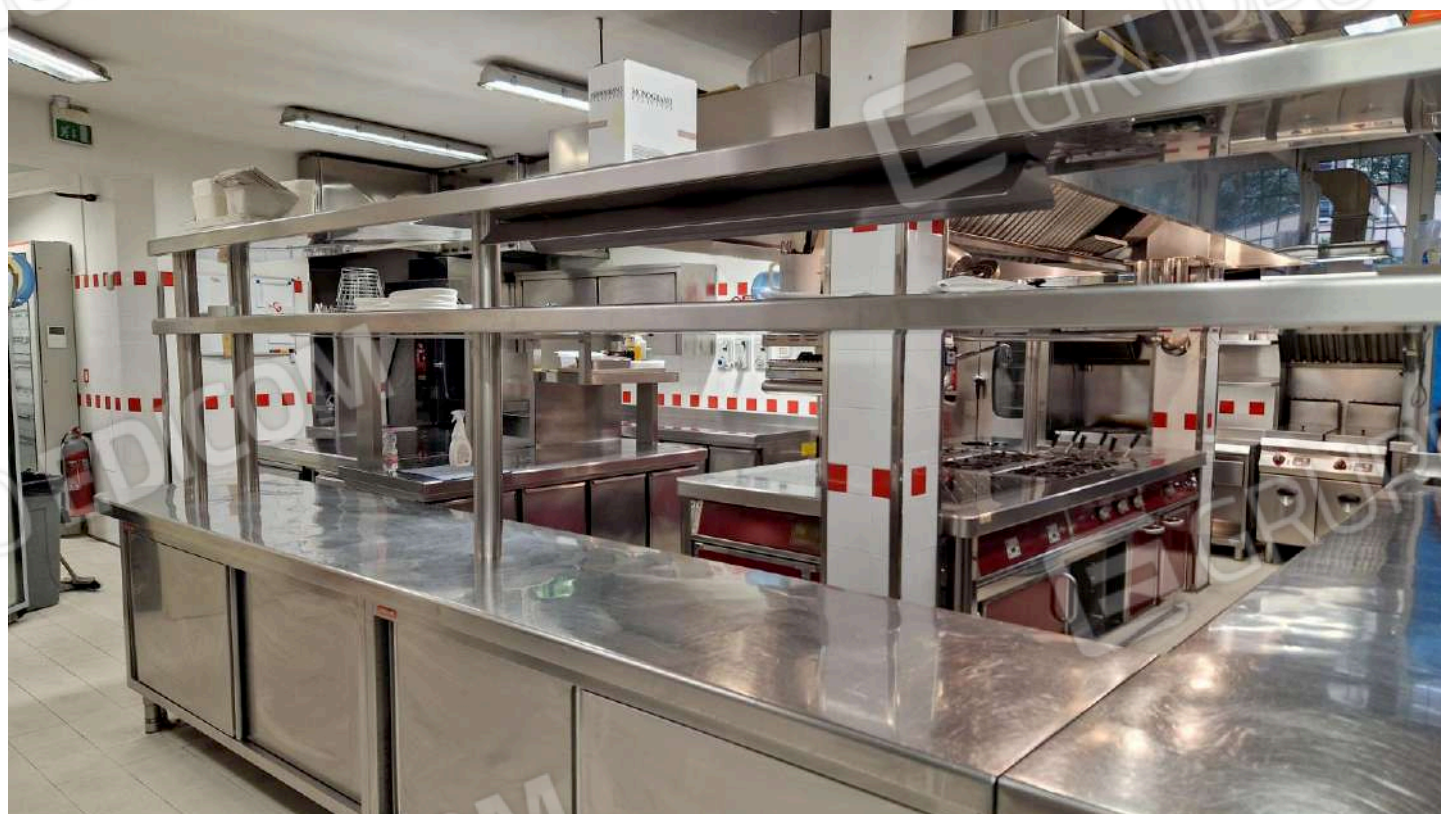
Cucina – vista verso l'accesso alla zona di servizio lato sinistro
