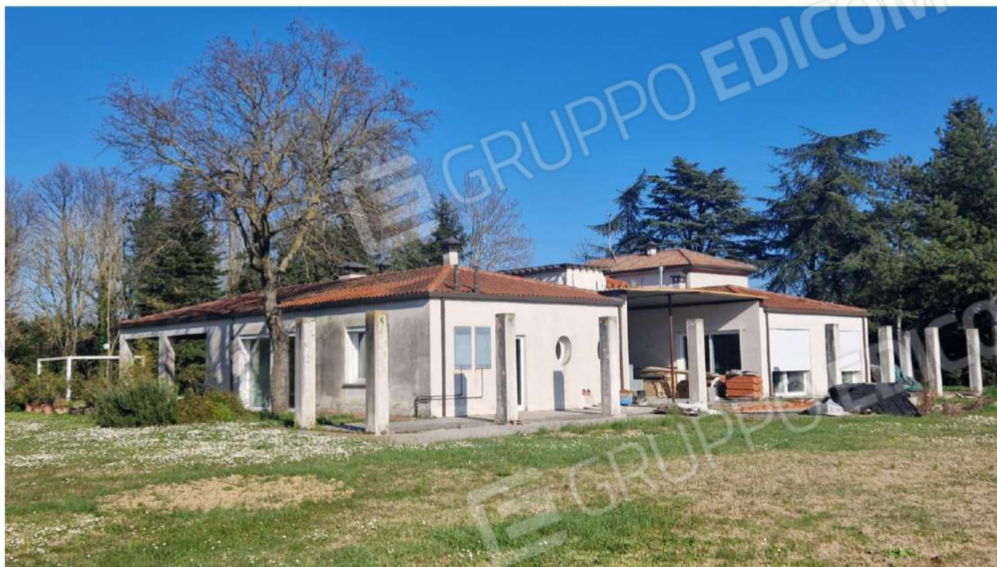
Vista laterale sud-ovest / retro
