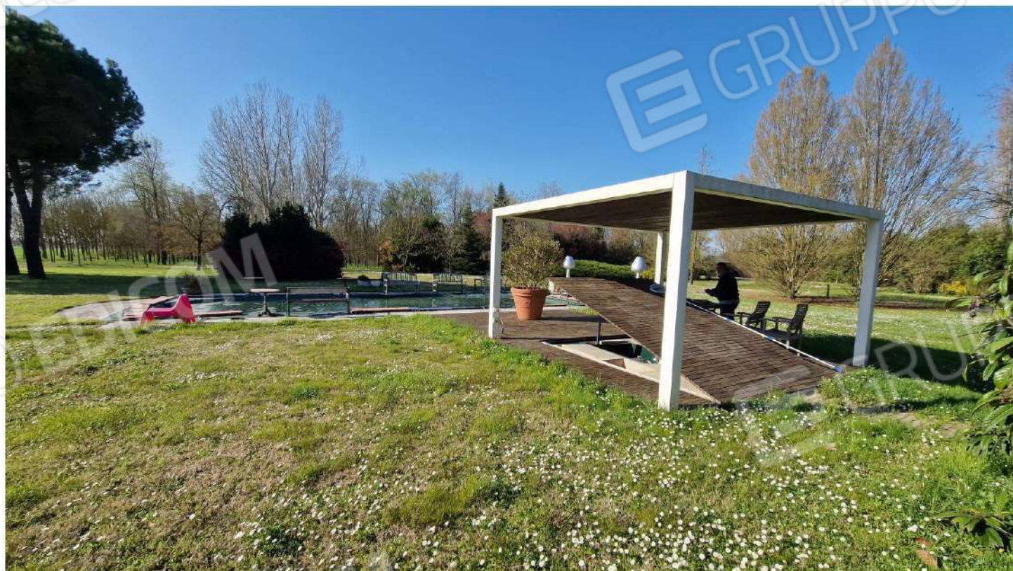
Manufatto coperto – impianti piscina (vista particolare)
