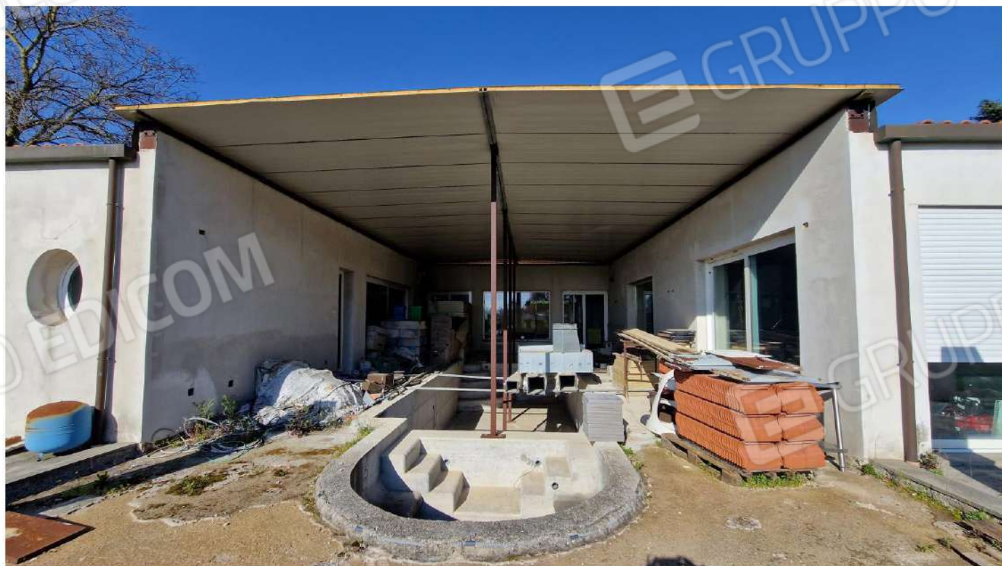
Vista laterale sud-ovest (particolare zona piscina coperta)
