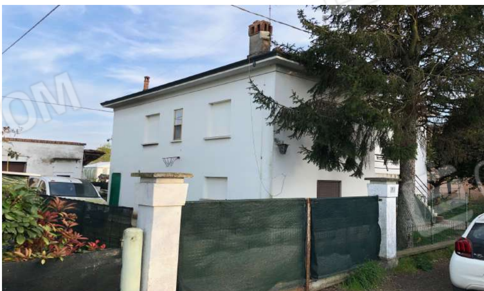
Vista generale dell'edificio da via E. Curiel.
