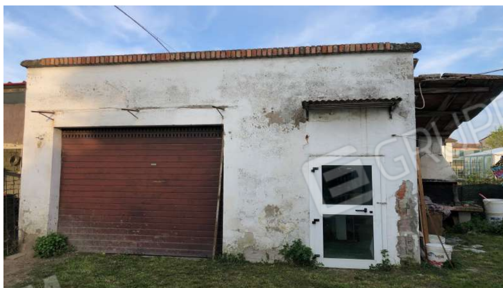
Vista servizi in corpo staccato, garage e ripostiglio.
