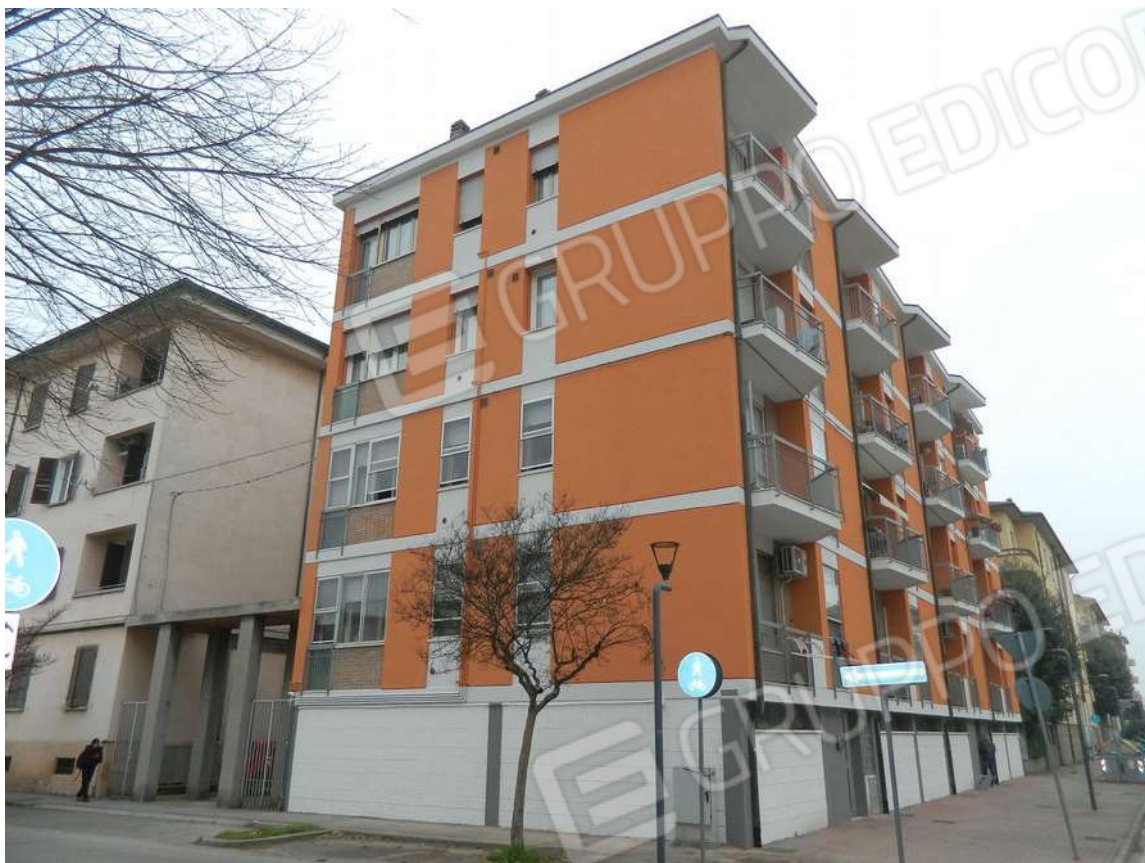
FOTO 3 – Fabbricato da via Tommaso Gulli
