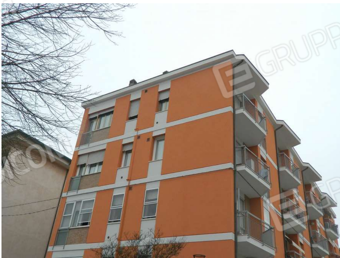
FOTO 4 – Appartamento a piano quarto da via Gulli
