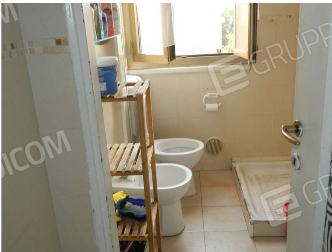
FOTO 14 – Bagno: dettaglio sanitari
