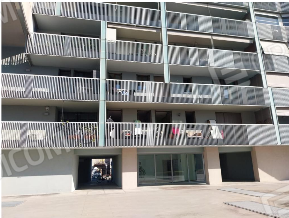
Foto 2 – Lato unità abitativa
