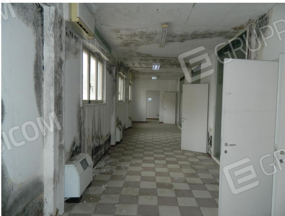
FOTO 12 – Disimpegno uffici a piano terra rialzato
