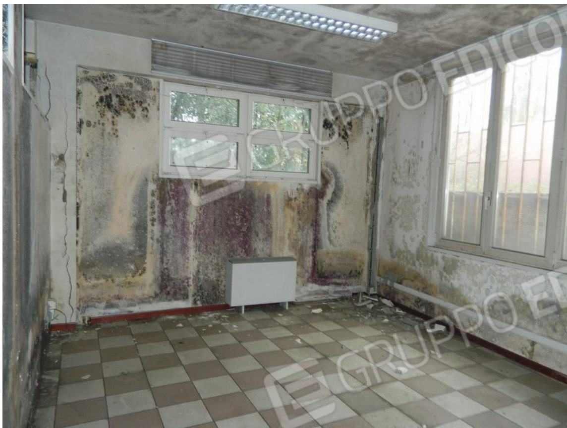
FOTO 13 – Uffici a piano terra rialzato
