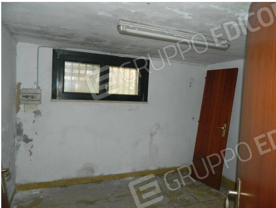
FOTO 19– Deposito a piano seminterrato
