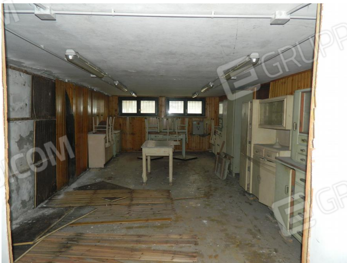
FOTO 18 – Deposito a piano seminterrato
