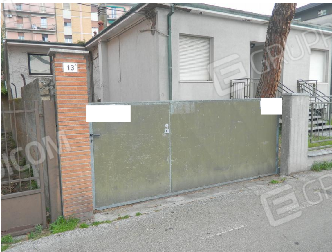
FOTO 4 – Ingresso carrabile da via Canalazzo
