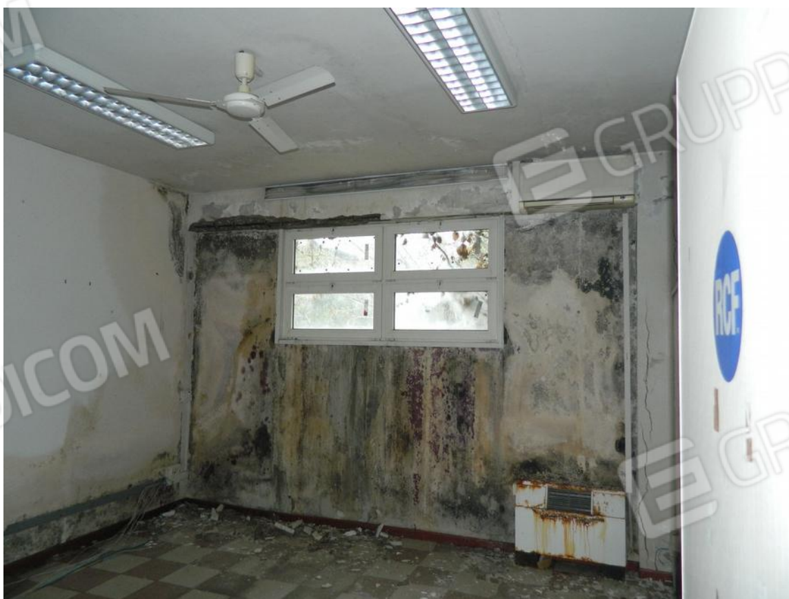
FOTO 14 – Uffici a piano terra rialzato
