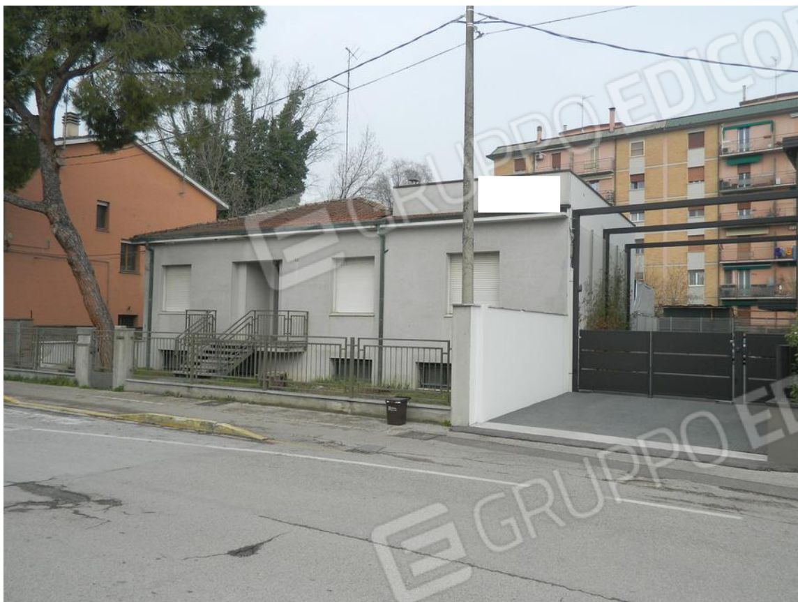
FOTO 1 – Immobile da via Canalazzo
