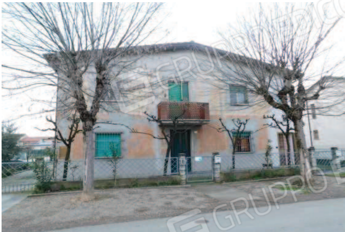
Foto 1 – Vista del fabbricato da Via Paolo Fabbri.
