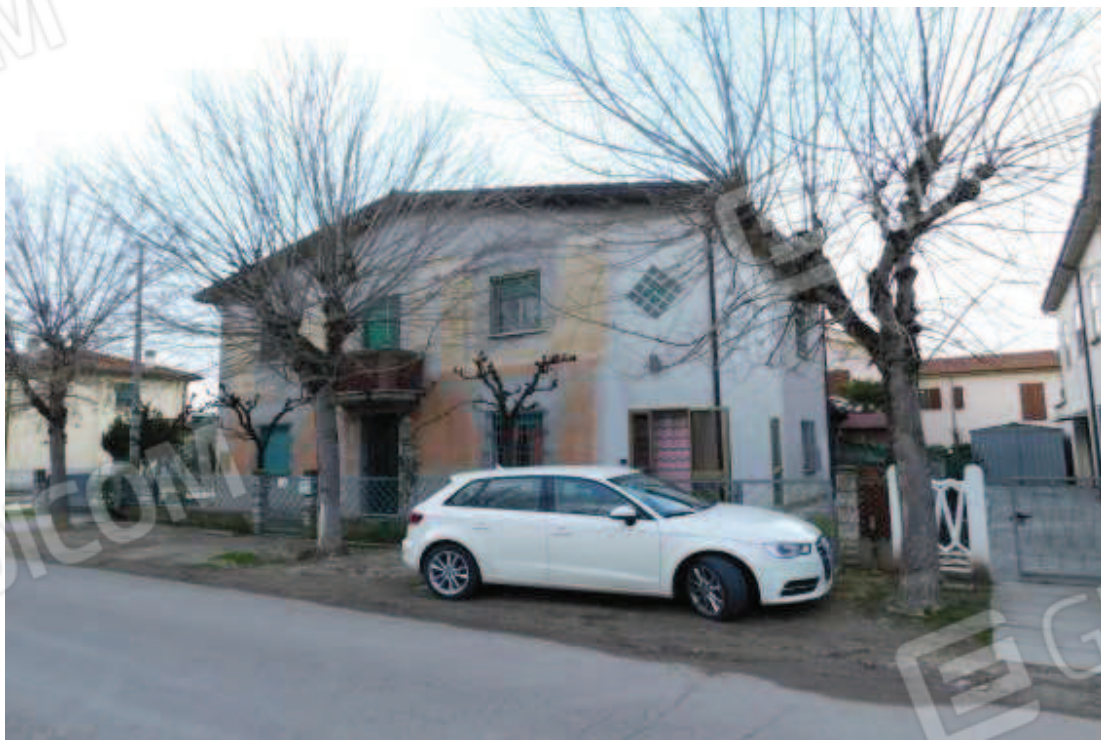
Foto 2 – Vista del fabbricato da Via Paolo Fabbri.
