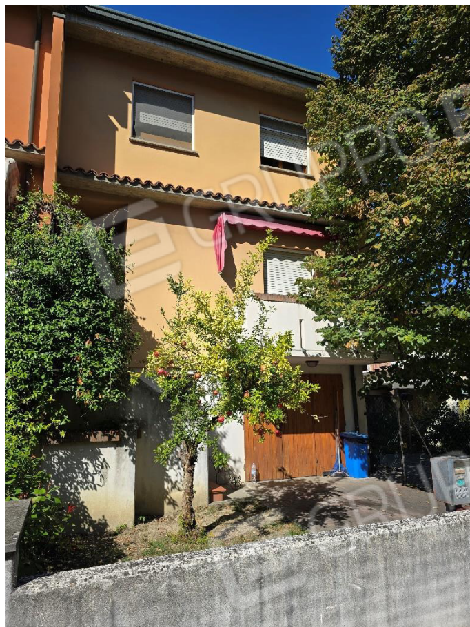
Fronte principale su Via Del Mulino
