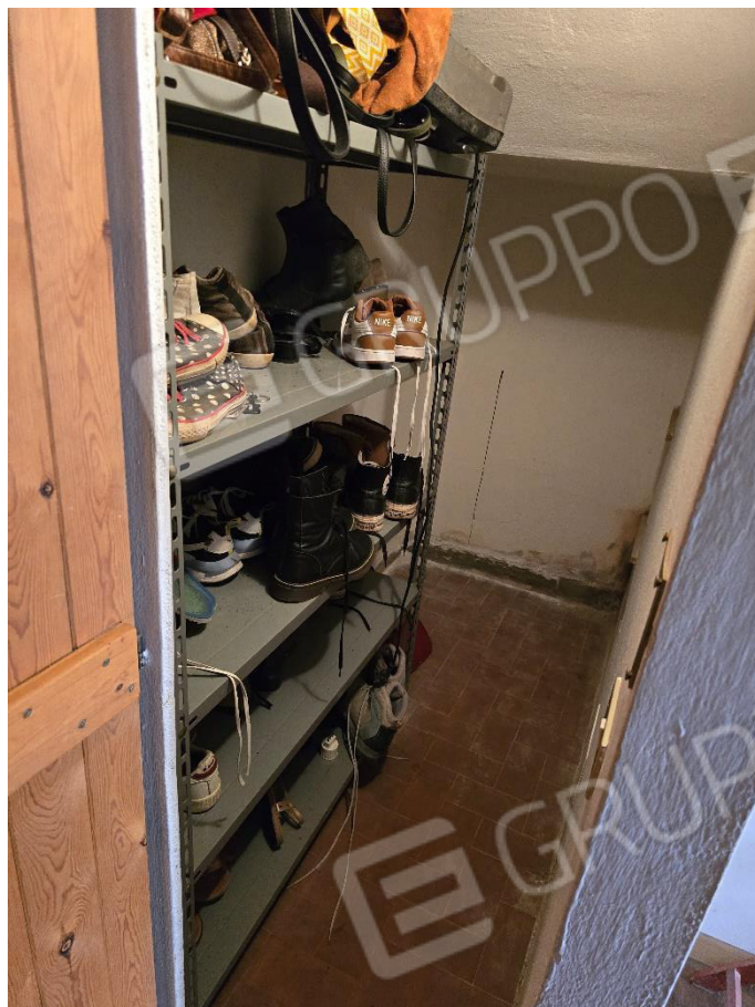
Sottoscala con probabile umidità di risalita
