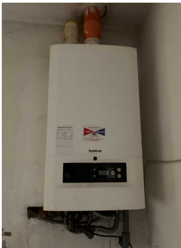
PARTICOLARE CALDAIA A CONDENSAZIONE INSTALLATA NEL 2008
