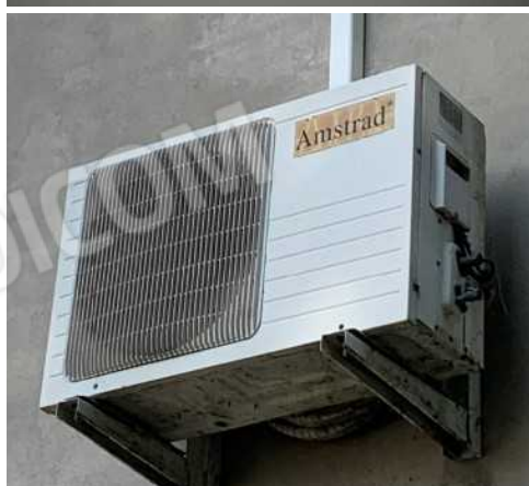
PARTICOLARI: SPLIT INTERNO ALLA CAMERA P.1 PER CONDIZIONAMENTO, UNITA' ESTERNA
