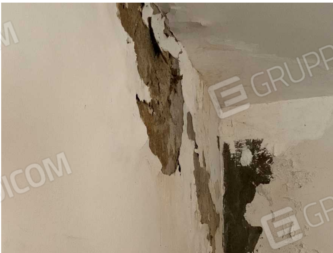
VANO SCALA PIANO PRIMO: PARTICOLARE DEGRADO INTONACO PER INFILTRAZIONI DALLA COPERTURA
