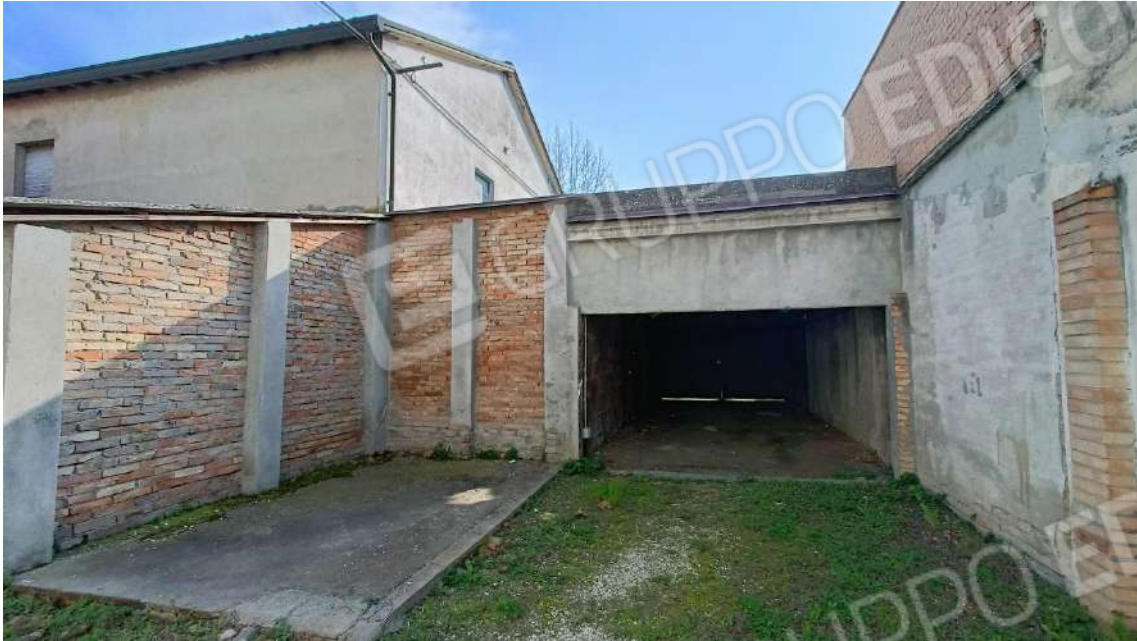
Vista del passo carraio comune dalla corte interna.
