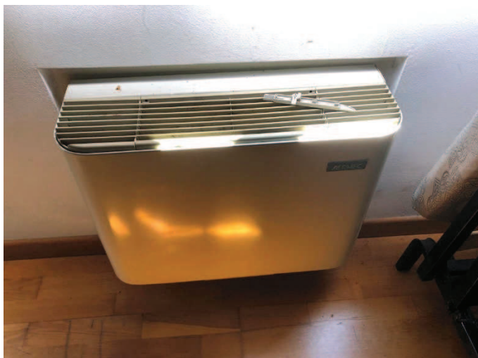
Foto n. 21 – ventilconvettore
