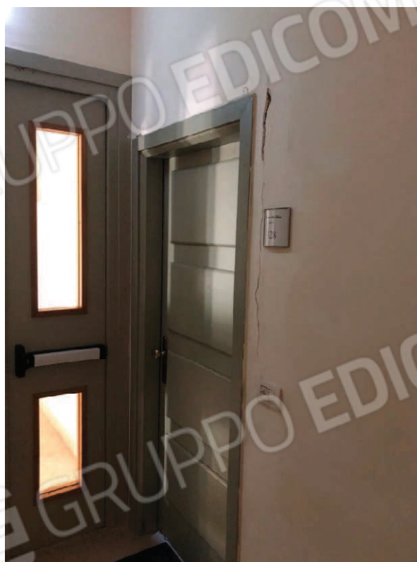
Foto n. 3 – ingresso all'unità n. 328
