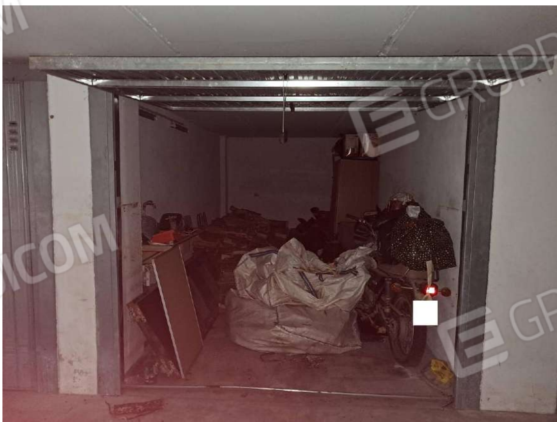
PIANO SOTTOSTRADA: INTERNI DELLA AUTORIMESSA SUB 11
