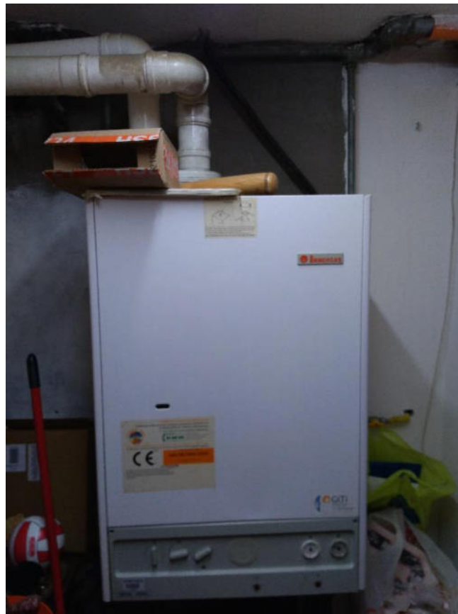
15. Caldaia murale tipo C
