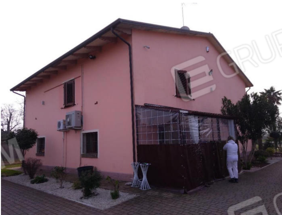
2- Retro edificio con tettoia da rimuovere
