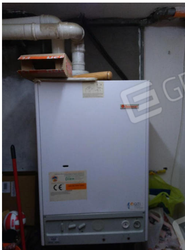
15. Caldaia murale tipo C
