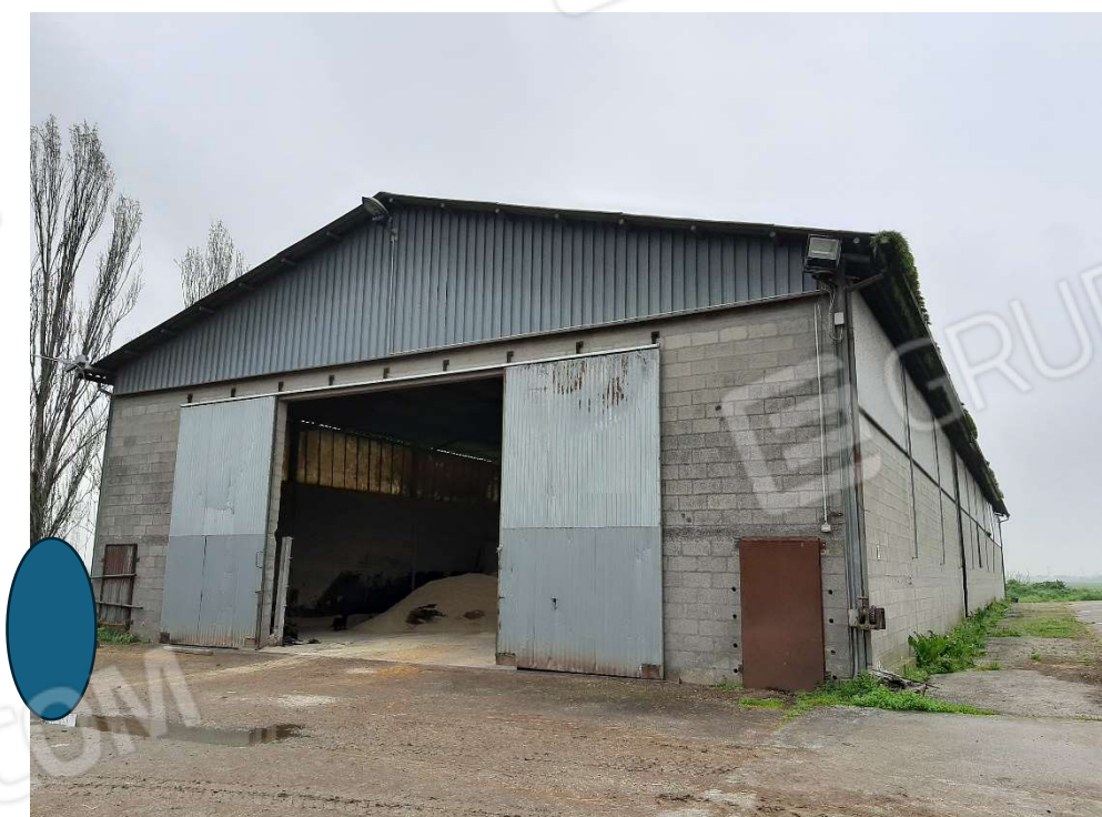
Foto 27 – Subalterno 6 – fabbricato “D”
