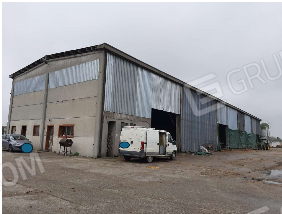
Foto 15 – Sub. 6 fabbricato "A"
