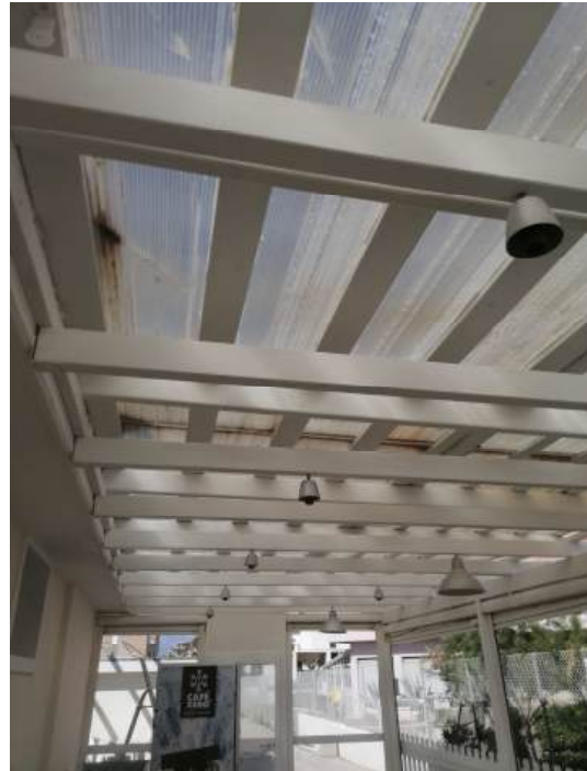
1) Realizzazione di struttura in legno verandata e coperta con lastre in policarbonato
