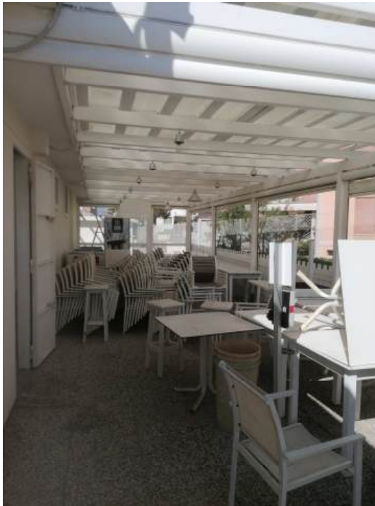
1) Realizzazione di struttura in legno verandata e coperta con lastre in policarbonato
