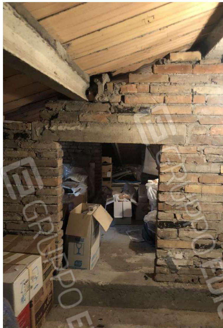
Foto 28: Particella 105, Subalterno 3, piano sottotetto
