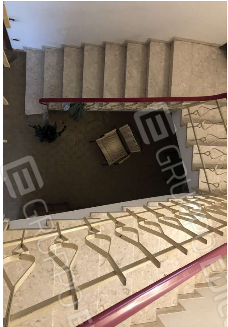
Foto 12: Particella 105, Subalterno 3, piano T
