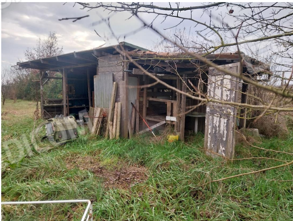
Foto 27. Manufatto da demolire
