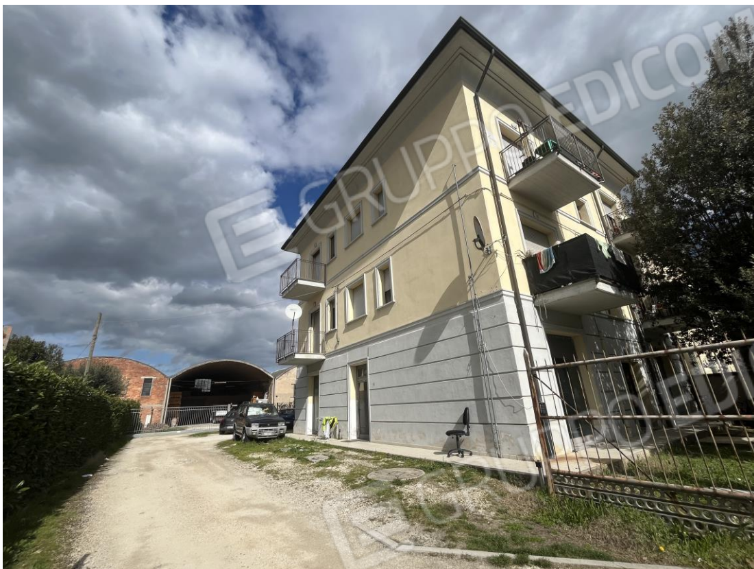
Fabbricato da via della Libertà (fronte ovest)
