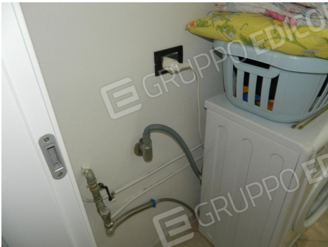
FOTO 15 – Cantina dettaglio: attacchi lavatrice e adduzione acqua
