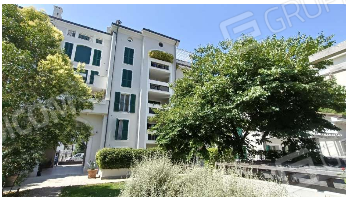
VISTA DEL FABBRICATO DAL CORTILE INTERNO
