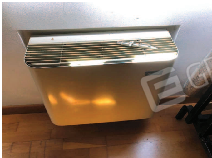
Foto n. 21 – ventilconvettore
