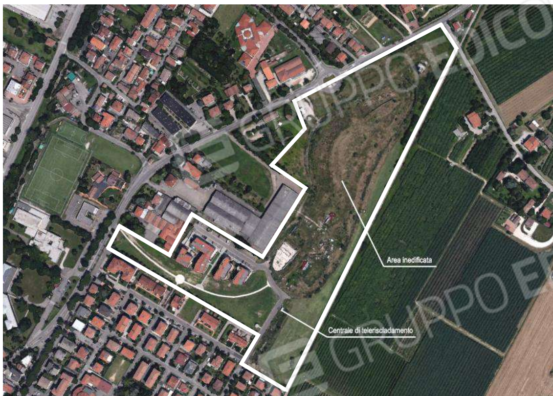
Foto 1: Vista aerea – Perimetro area di interesse
