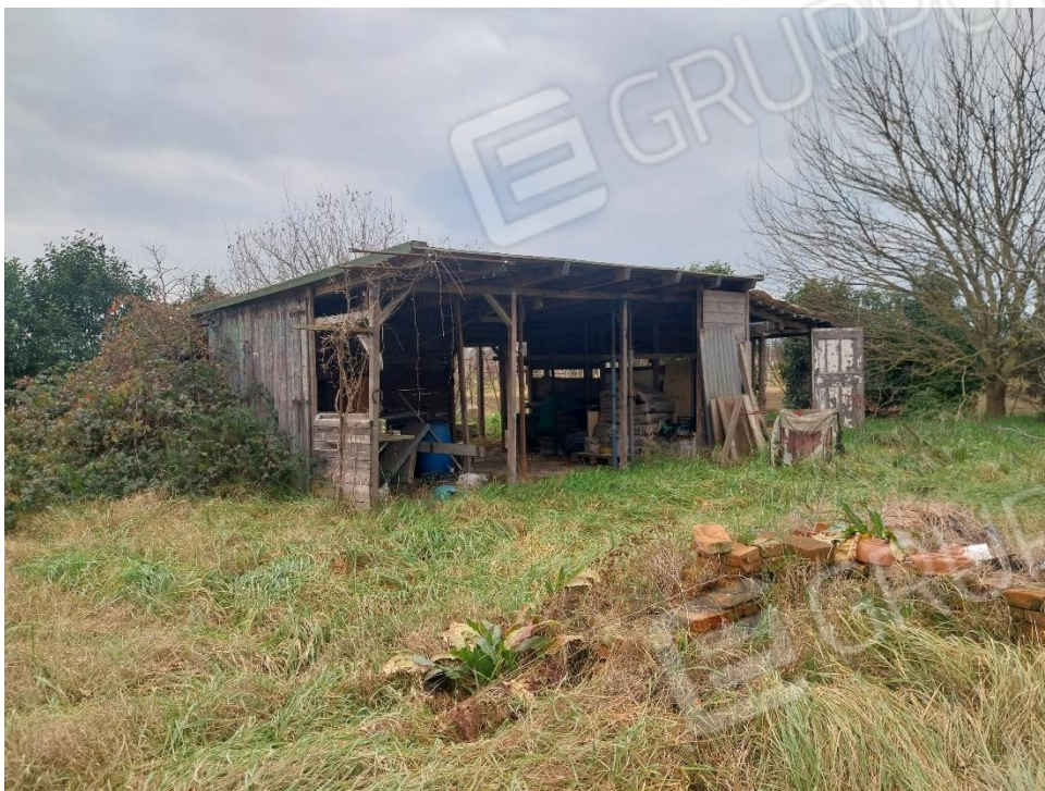
Foto 27. Manufatto da demolire
