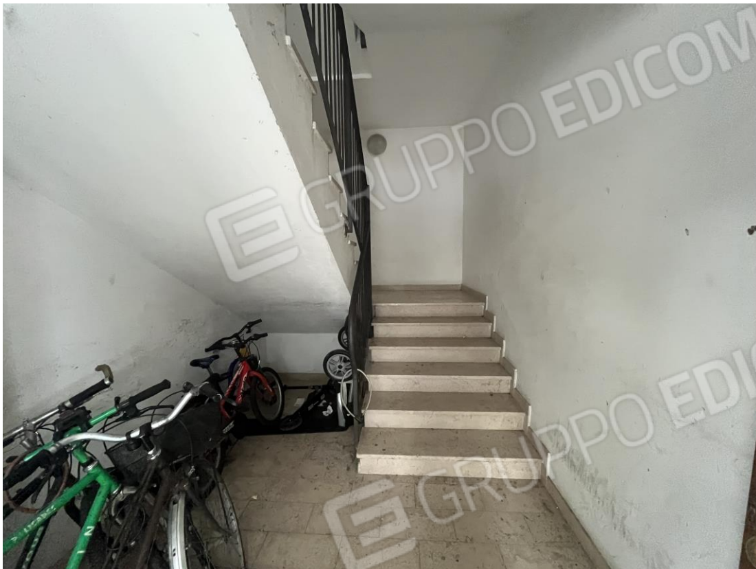
Ingresso piano terra e scala comune
