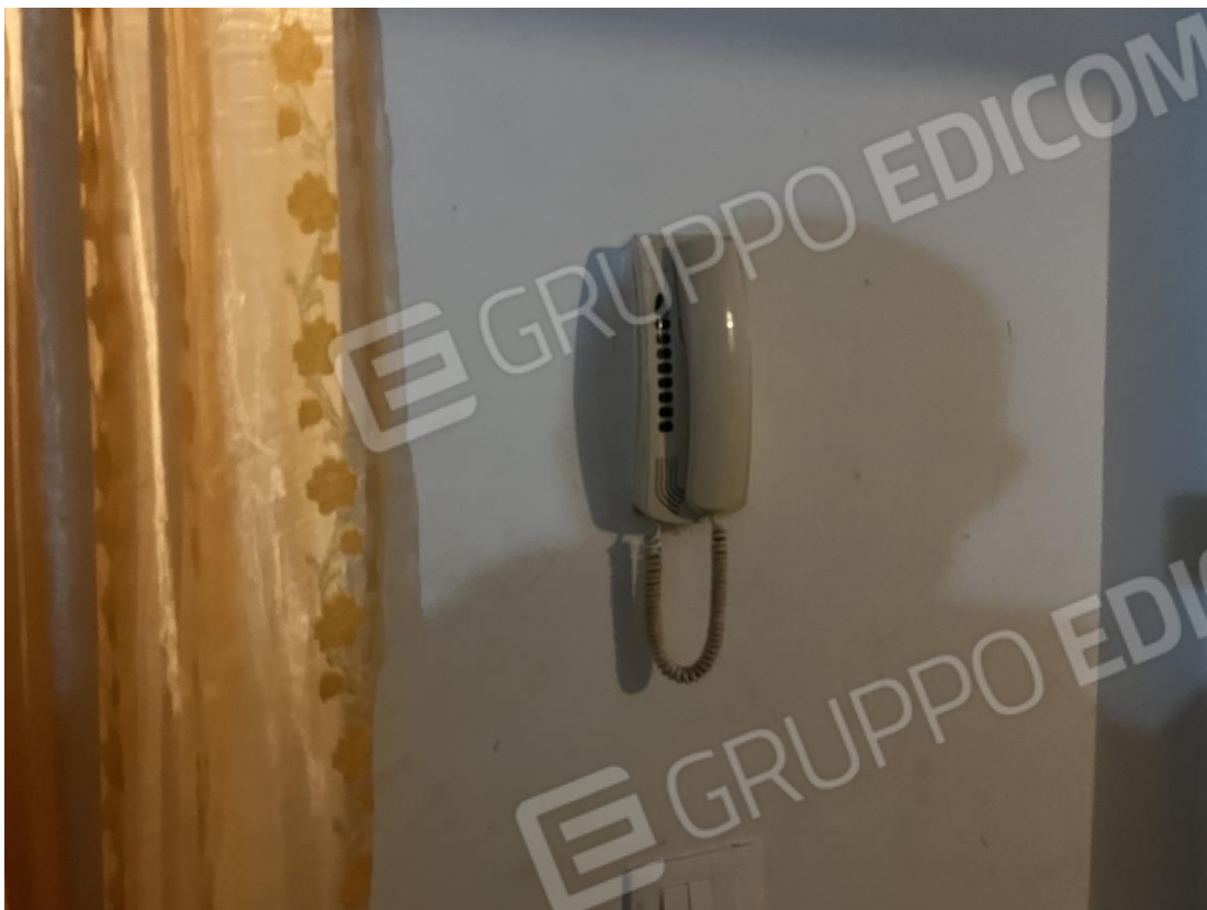
Citofono e termostato posto nell'ingresso
