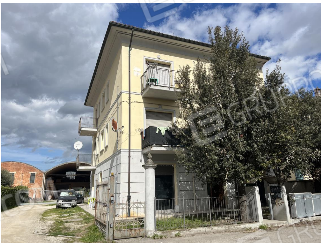
Fabbricato da via della Libertà (fronte sud)
