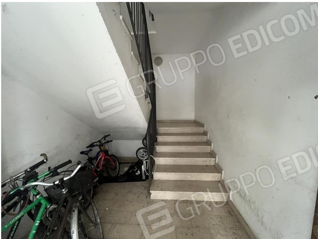
Ingresso piano terra e scala comune
