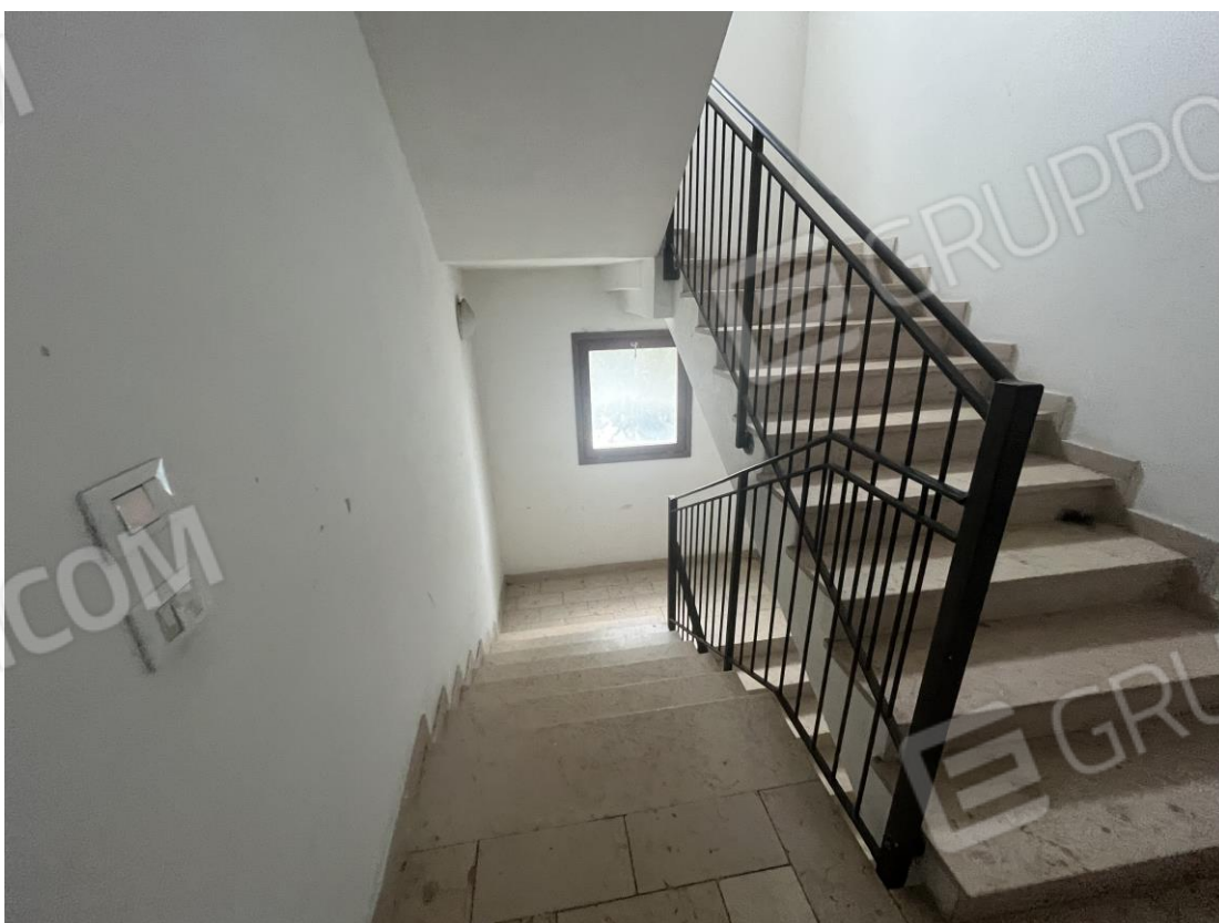
Vano scala comune
