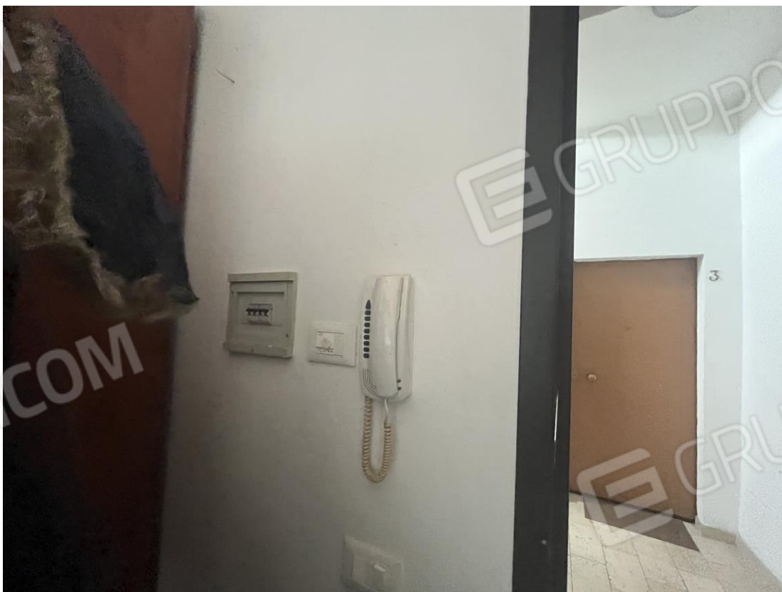
Quadro elettrico, citofono e termostato posti adiacenti alla porta di ingresso
