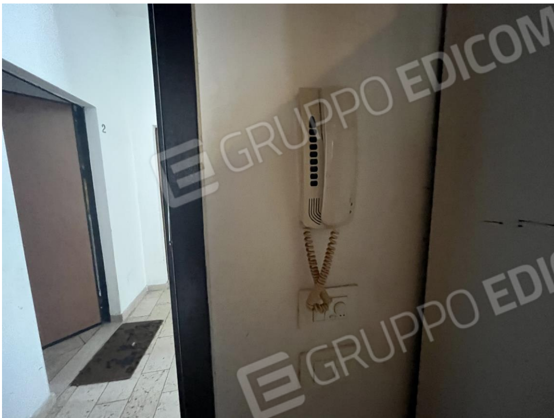
Citofono posto adiacente alla porta in ingresso
