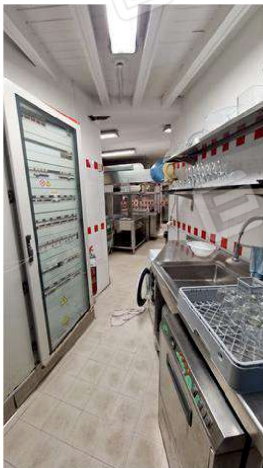
Altra vista opposta verso la cucina
